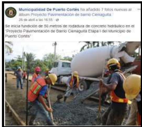
COBERTURA AVANCE PAVIMENTACIÓN DE BARRIO CIENAGUITA
