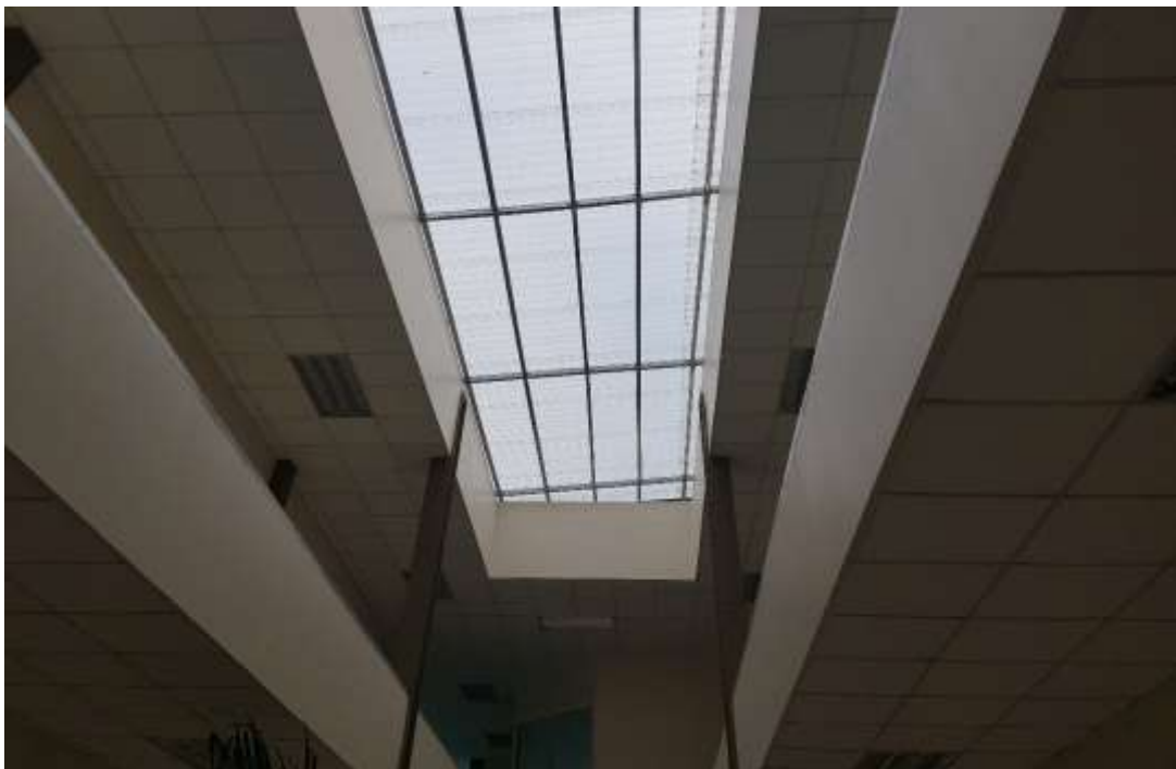
Cubierta de Techo
