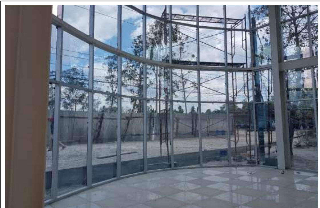
Refuerzo para Ventanas
