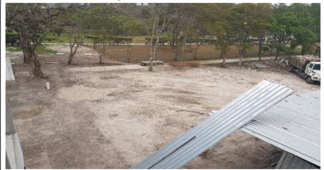
Limpieza del Área de trabajo
