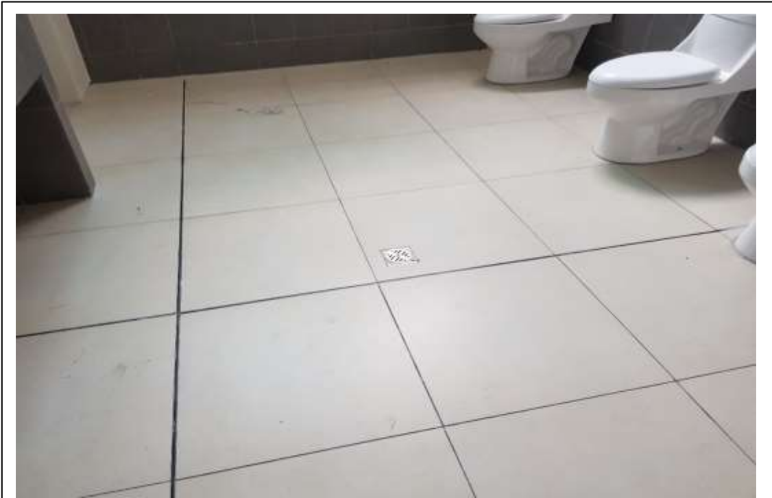
Drenaje de baños
