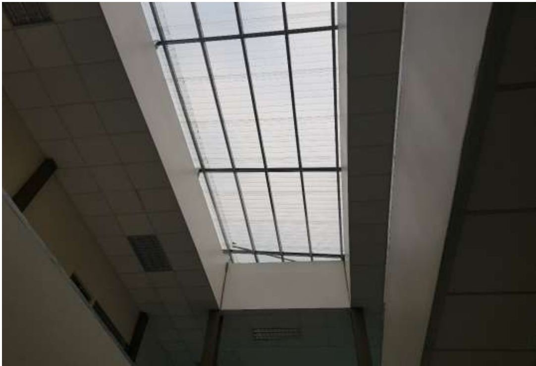
Cubierta de Techo
