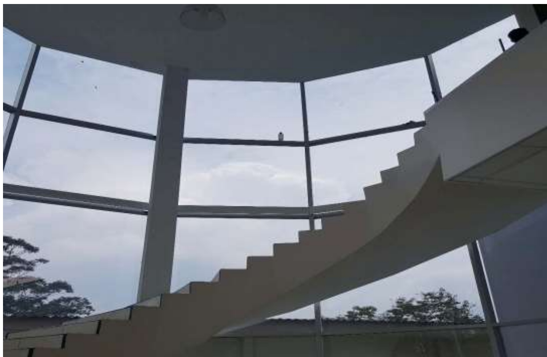
Refuerzo para Ventanas
