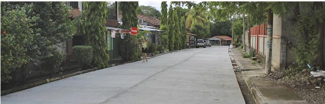
El sistema anterior se refiere a un recubrimiento de concreto con cemento, construido sobre una base existente, el resultado tras su aplicación es un pavimento de gran calidad que brinda una larga vida útil en buenas condiciones de operación, explicó el funcionario.
