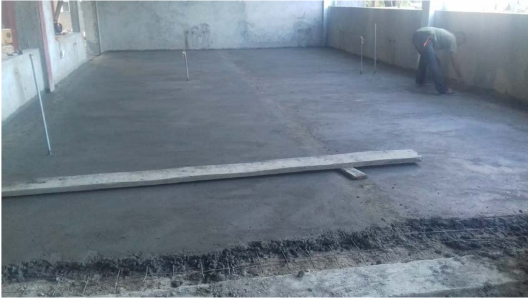
Firme de concreto de 5cm de espesor
