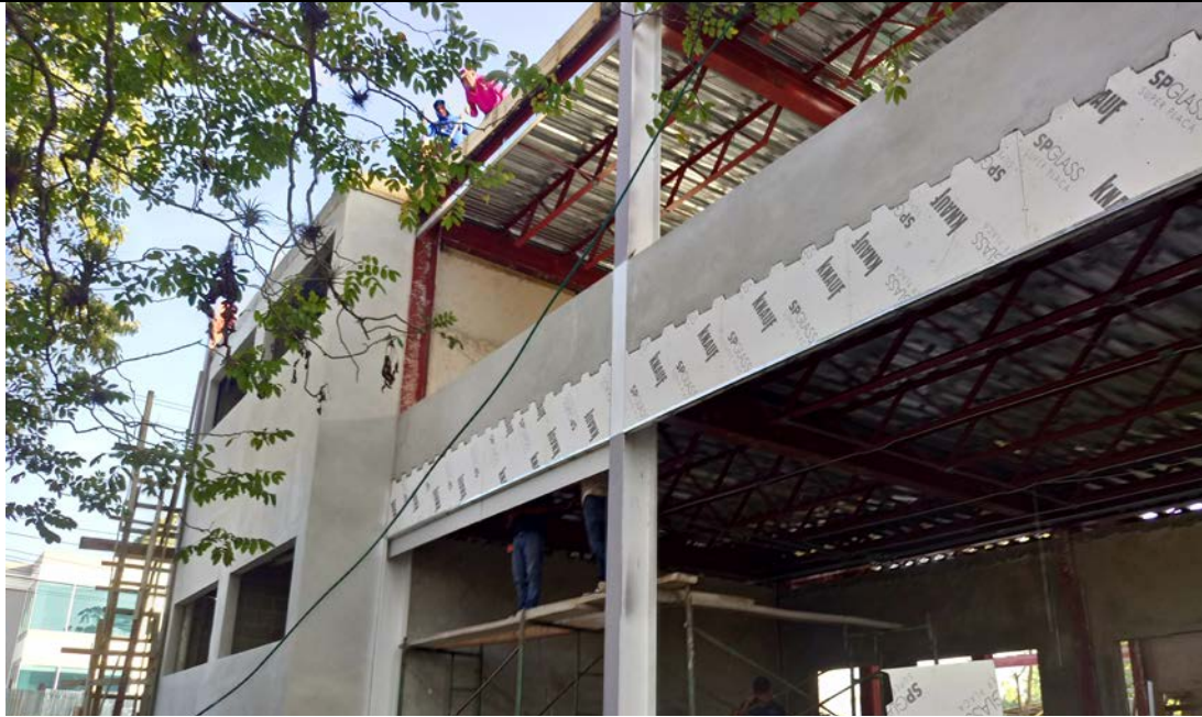
Fascia de tabla yeso en perímetro de ventanas
