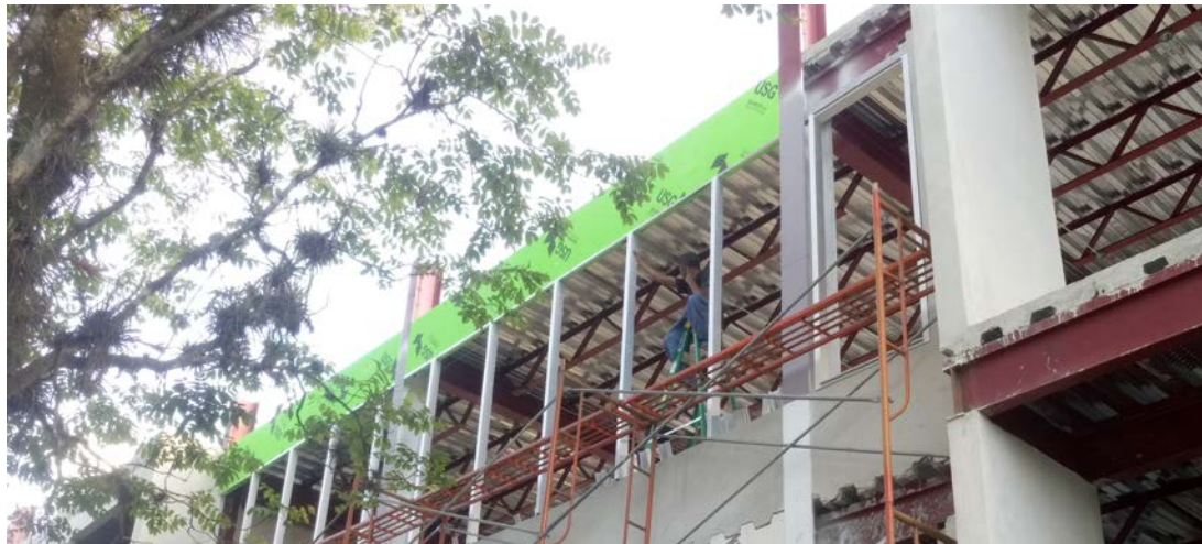
Fascia de tabla yeso en perímetro de ventanas
