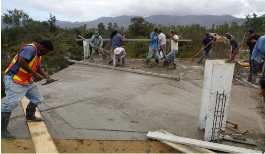
Concreto de 8cm de espesor
