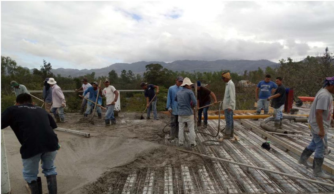
Concreto de 8cm de espesor
