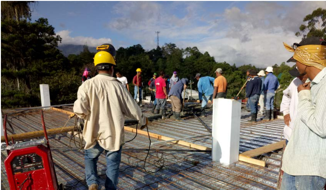
Concreto de 8cm de espesor
