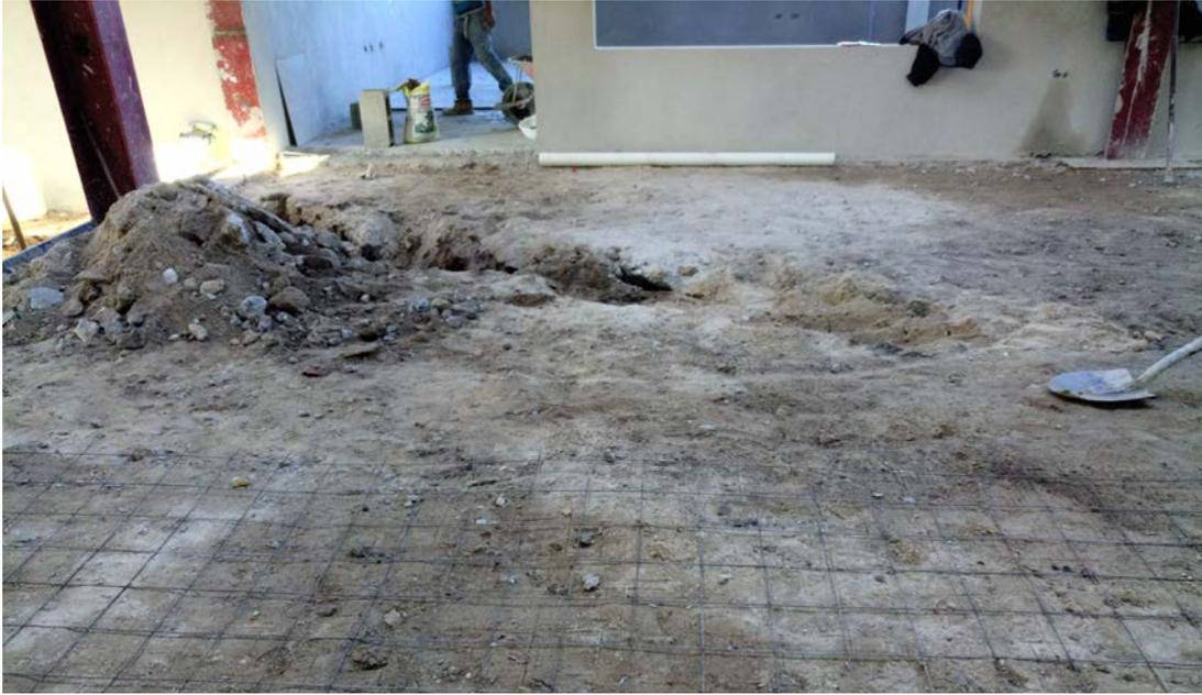
**Firme de concreto de 5cm de espesor**
