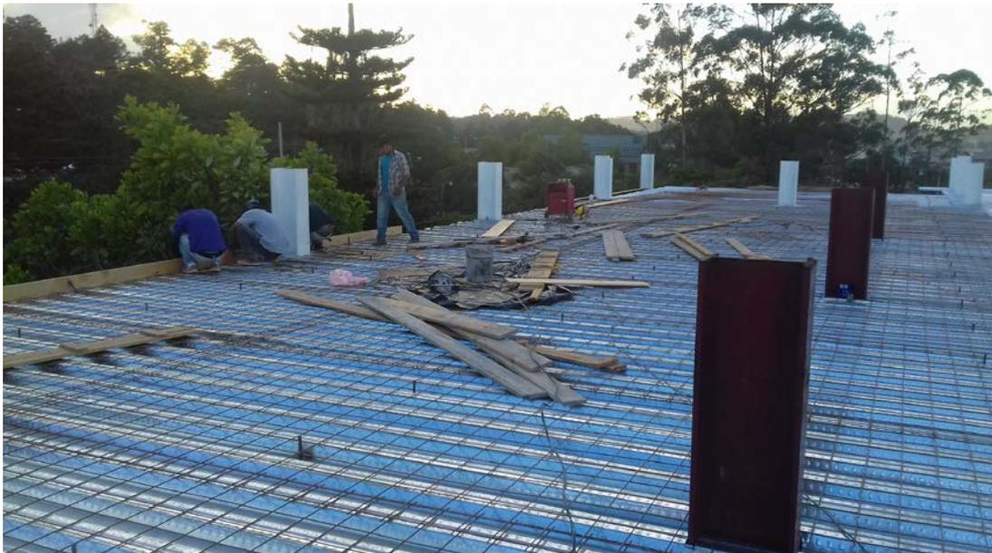
**Lamina de Aluzinc cal 24 y malla electrosoldada**
