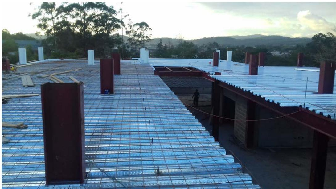
**Lamina de Aluzinc cal 24 y malla electrosoldada**
