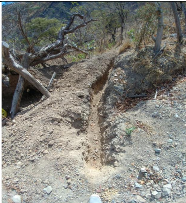
Excavacion para linea de conduccion.
