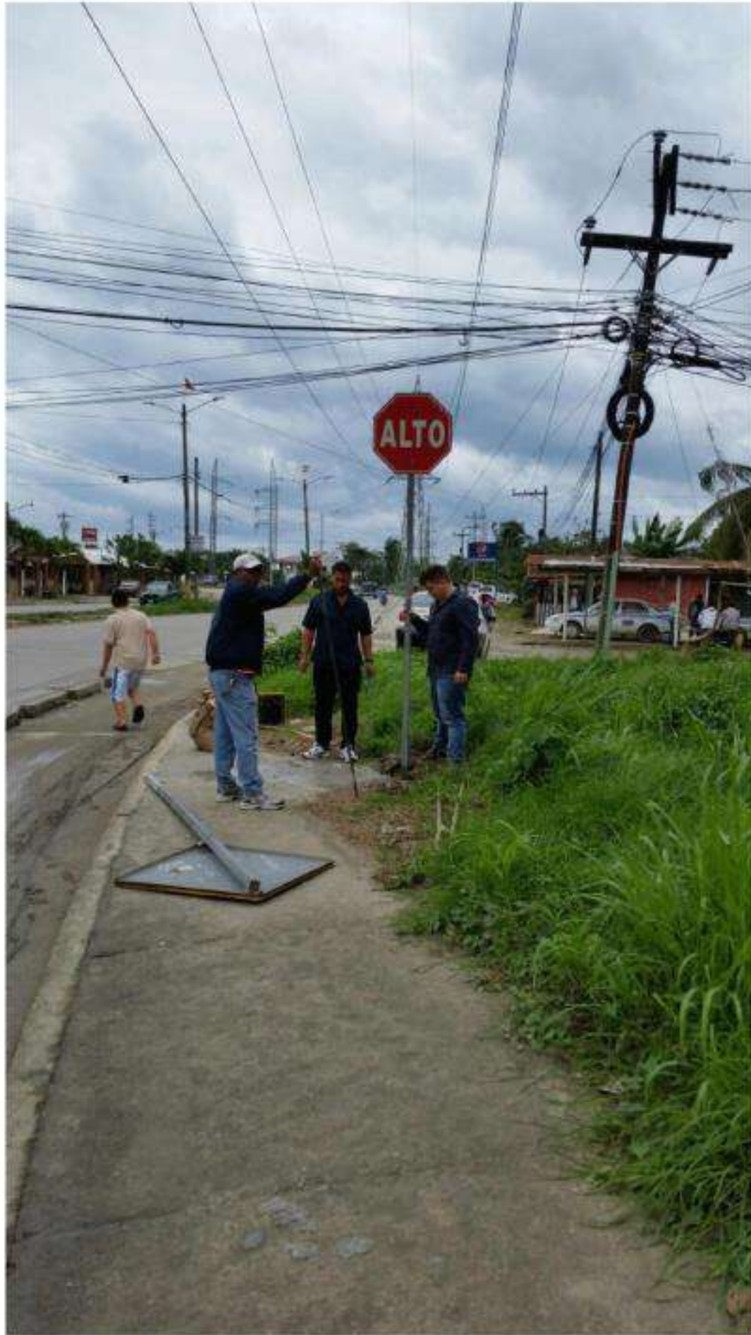
Instalación de señal de alto en el barrio la roca frente al cruce.
