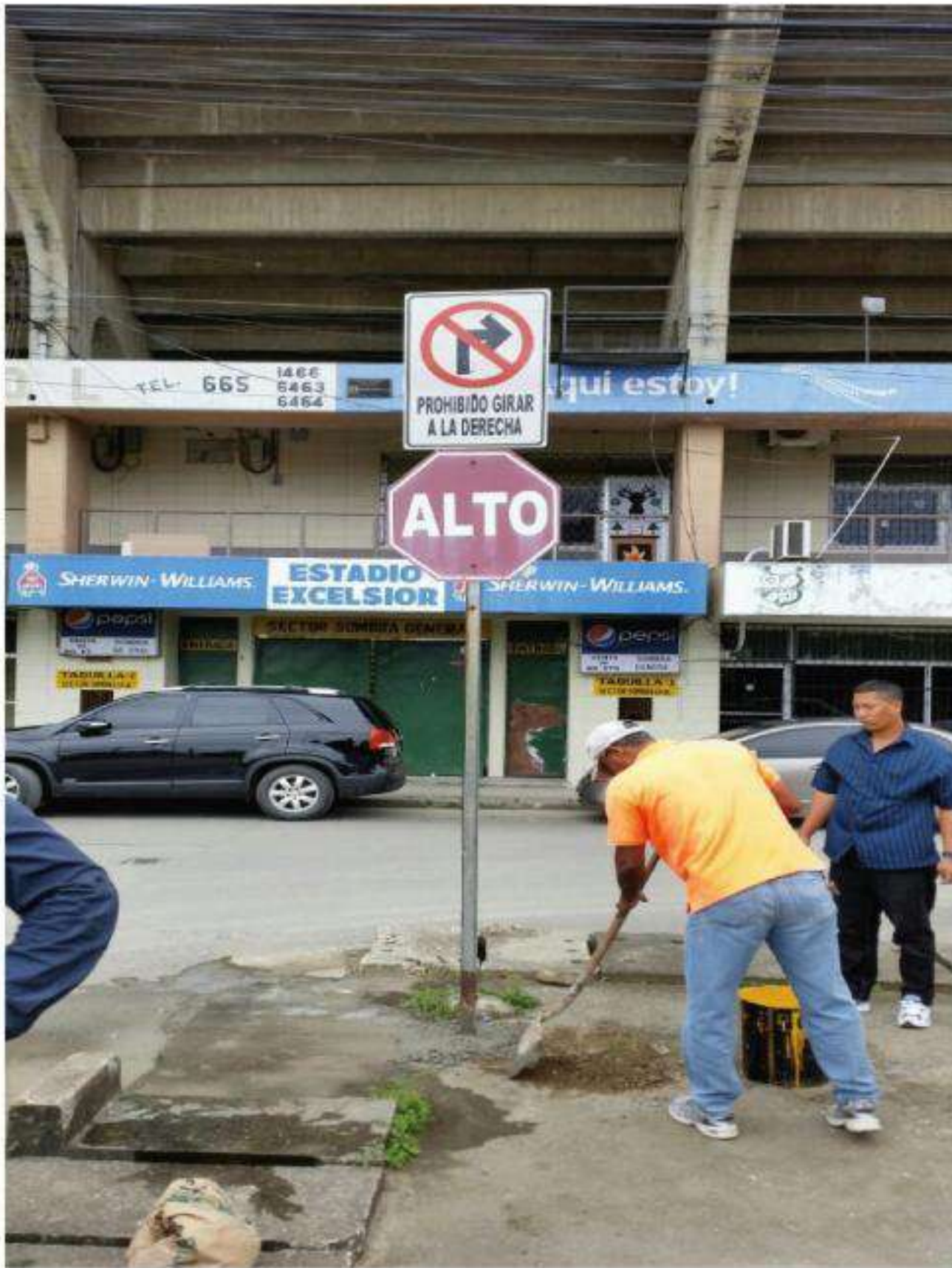
Instalación de señal de alto y no girar a la izquierda en el barrio copen 5ta avenida 9 calle frente al estadio.
