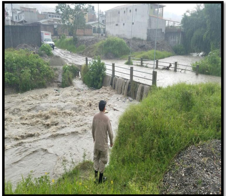
INSPECCION A QUEBRADAS
