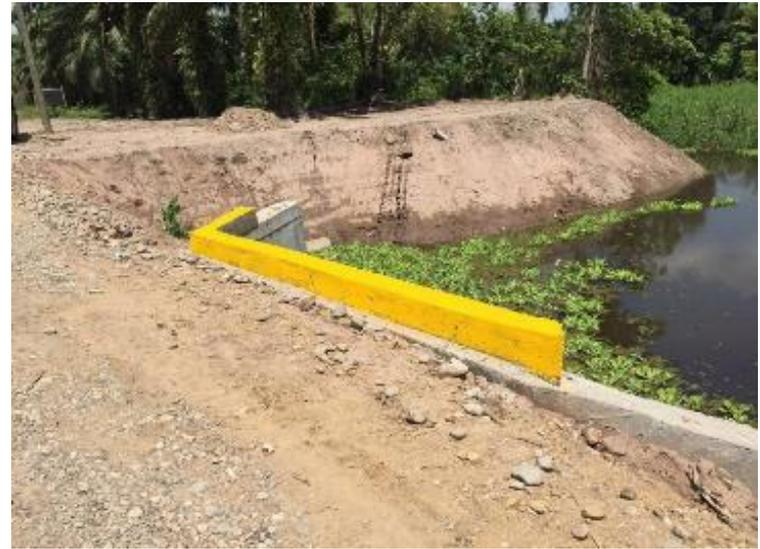
Construcción de alcantarilla de paso doble de 60" pulgadas de diámetro en tramo carretero, sector Tapón de Los Oros-La Puntilla.
