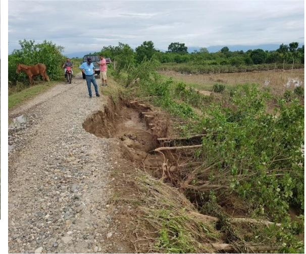
Cierre de boquetes, reconstrucción y sobreelevación de bordo margen derecha del Río Chamelecón, sector Guarumas II, Villanueva, Cortes.
