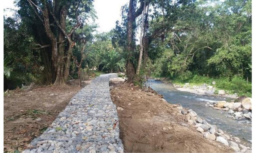
“Construcción de Muro de Gaviones Margen Izquierda del Rio Plátano, Sector la Ica”
