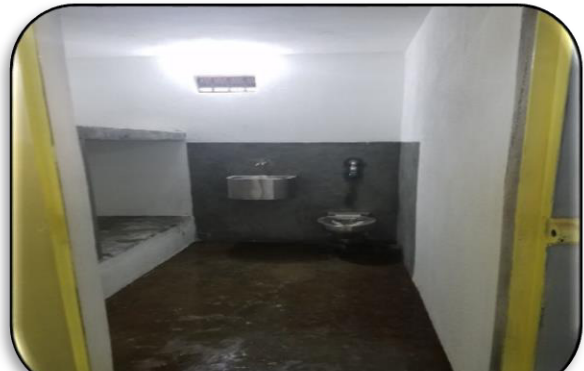
Colocación de lavamanos e inodoros
