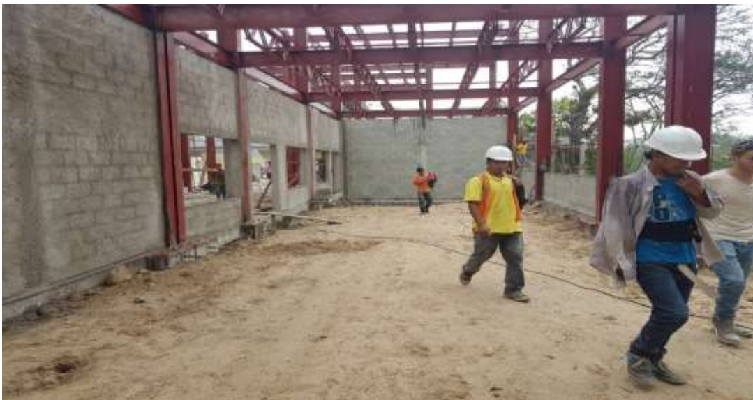
Limpieza en proyecto
