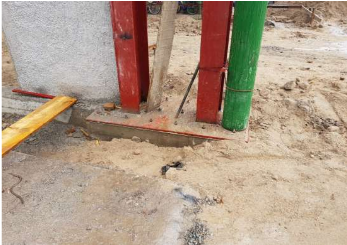
Mortero Autonivelante para Colocación de Placa
