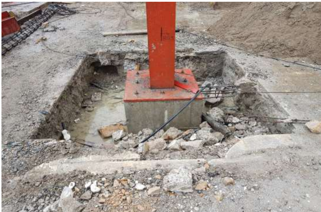
Mortero Autonivelante para Colocación de Placa
