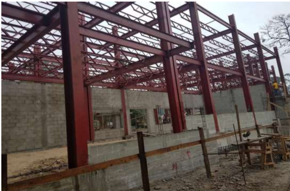
Columnas y Vigas de Diferentes Tamaños y Pesos
