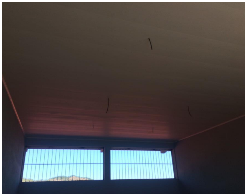
El cielo PVC fue colocado en su totalidad.
