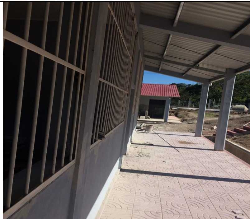
Modulo siendo preparado para la aplicación de pintura.
