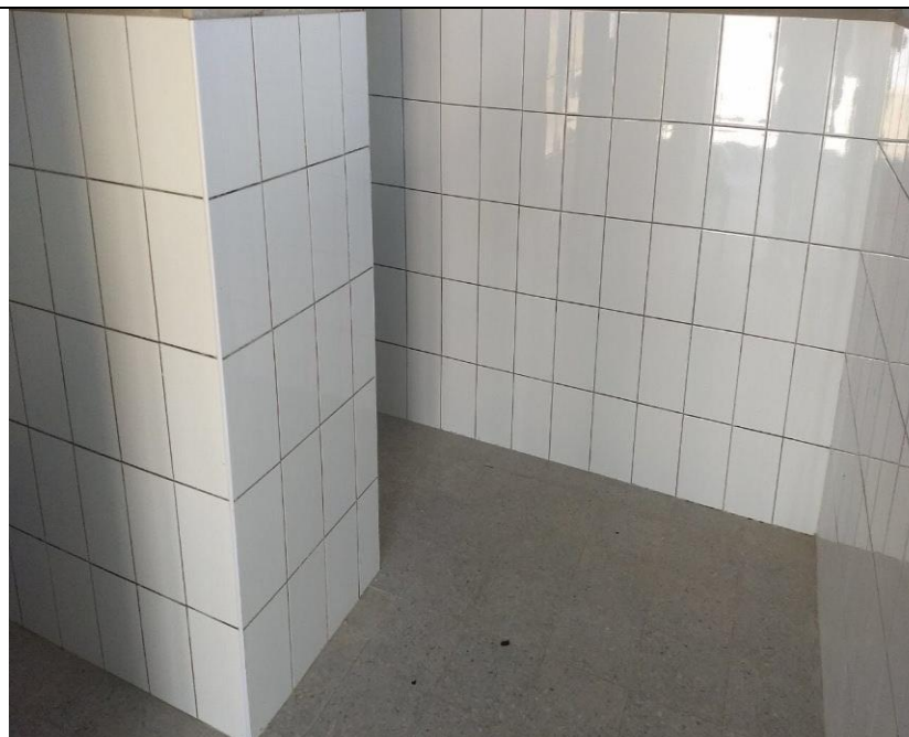
Cerámica de baños colocada totalmente.
