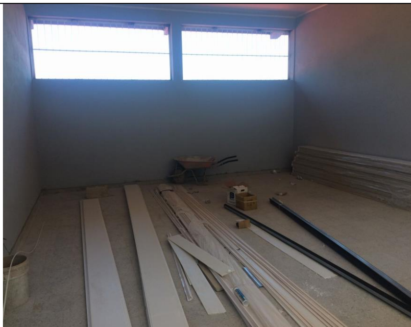
Finalización de colocación de sellador para pintura.
