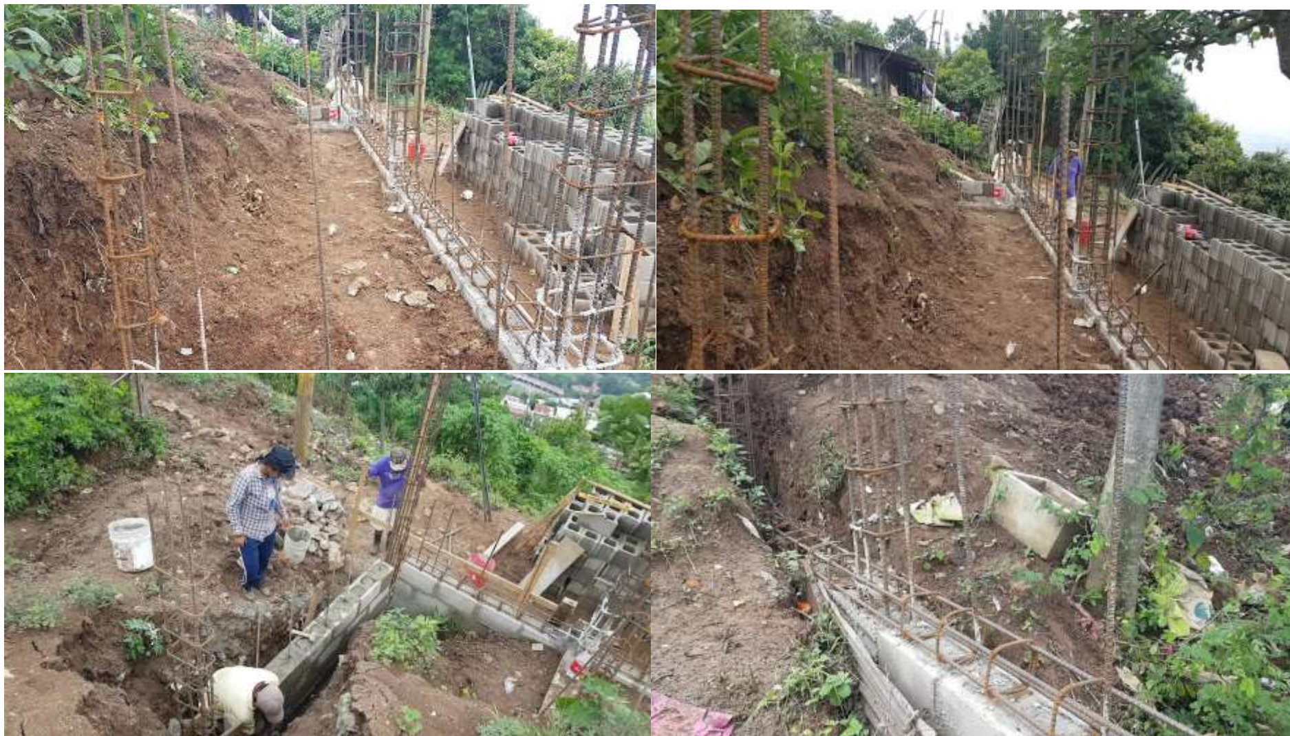
Avances construcción de cancha, mirador, mini parque, camerinos y cancha en colonia Villa cristina
