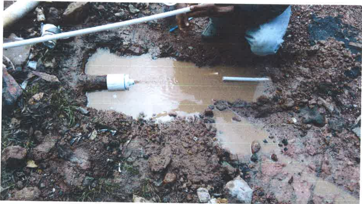
Reparaciones hechas recientemente.
