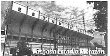
Renovación Estadio Morazan
