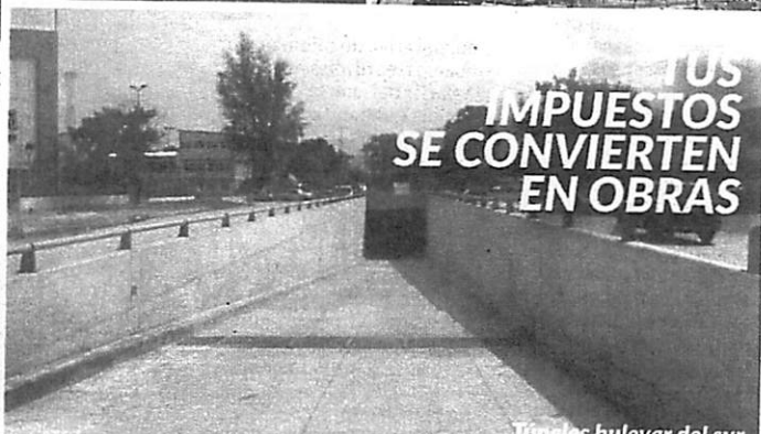
Túneles bulevar del sur
