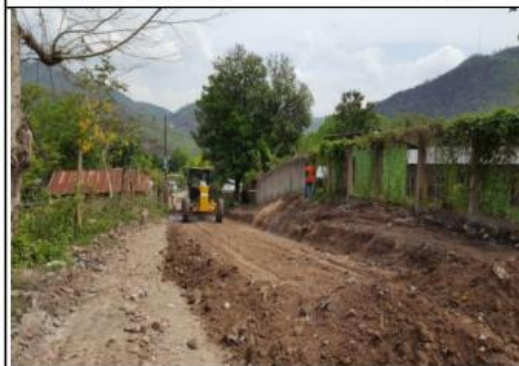
No. TRAMO: Itame-San Juan de La Cruz-San Jose de Oriente Estación: 0+320 11 Actividad: Reacondicionamiento de Calzada Fecha: 09-05-2017
