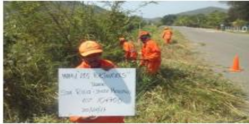
MAMV: Los Forjadores. Tramo: Ruta 23, Santa Rita Estación 0+000 – Estación 37+500. Del Depto. de Yoro.
