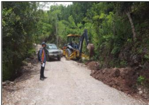
No. TRAMO: Itame-San Juan de La Cruz-San Jose de Oriente Estación: 2+667 9 Actividad: Limpieza de Alcantarilla Fecha: 25-05-2017
