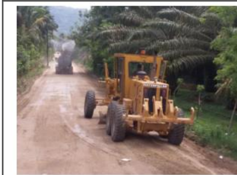
No. Tramo: RUTA CA. 13 - PLANES DE HICAQUE Estación: 0+000 3 Actividad: Conformación Tipo I Fecha: 05/05/17
