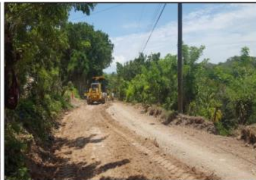
No. TRAMO: Itame-San Juan de La Cruz-San Jose de Oriente Estación: 5+805 10 Actividad: Reacondicionamiento de Calzada Fecha: 14-05-2017
