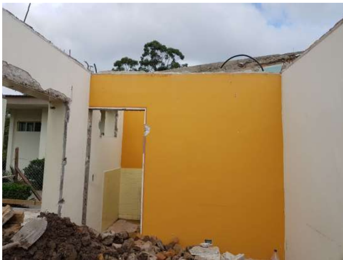
Demolición de la Cocina
