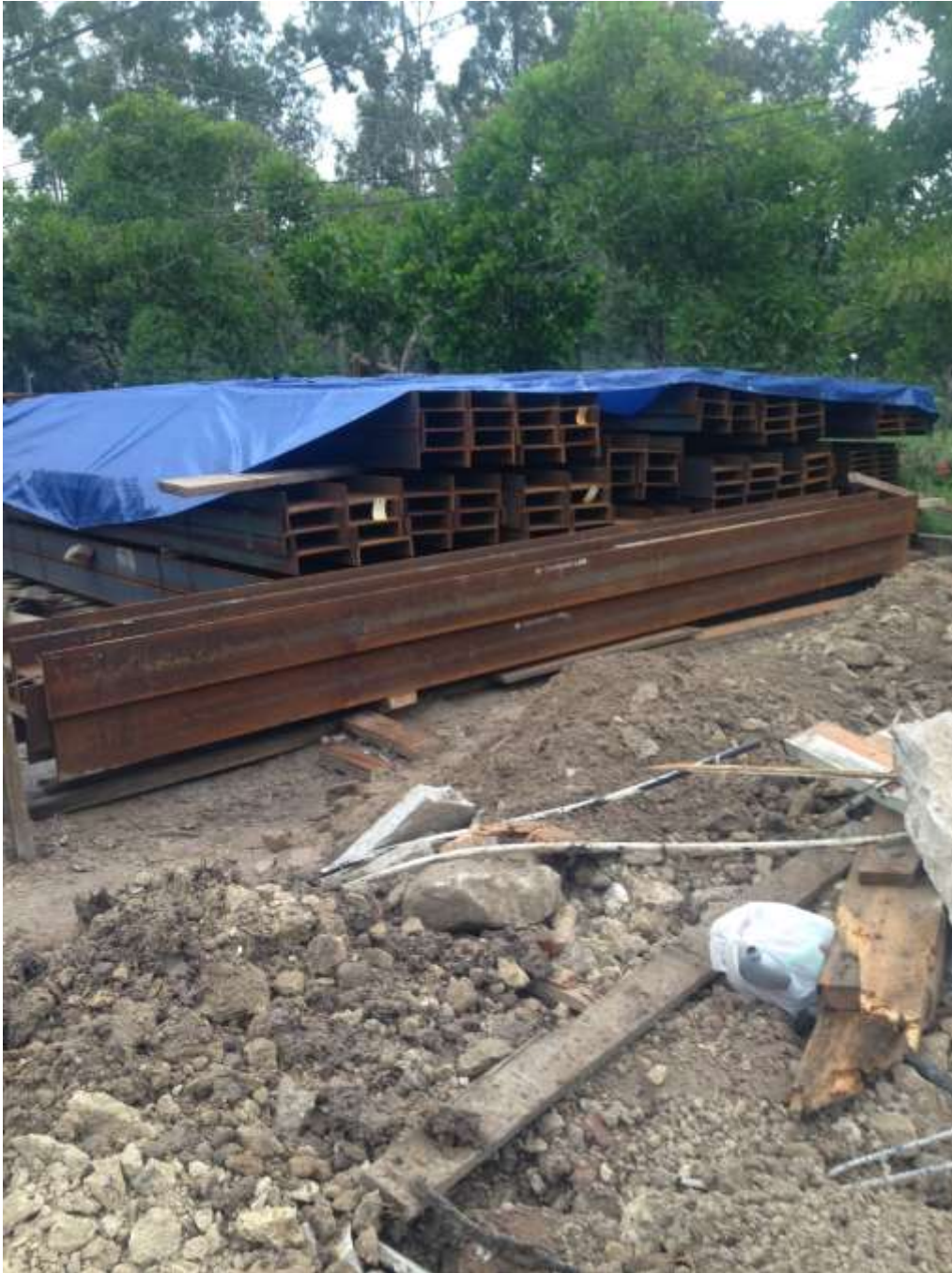
Columnas y Vigas de Diferentes Tamaños y Pesos
