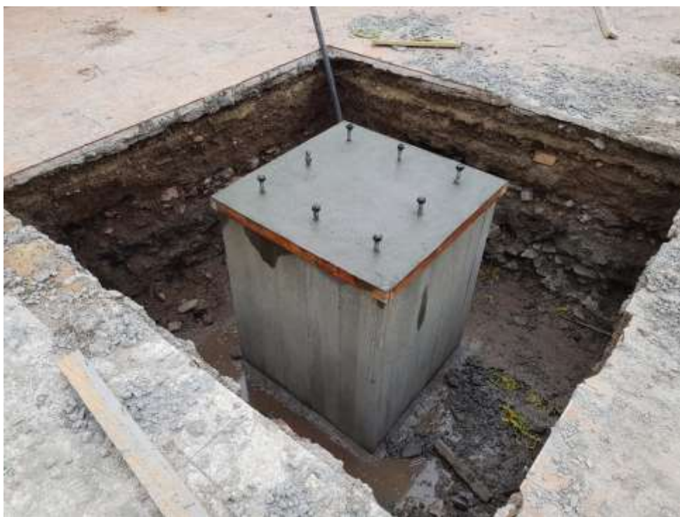
Mortero Autonivelante para Colocación de Placa
