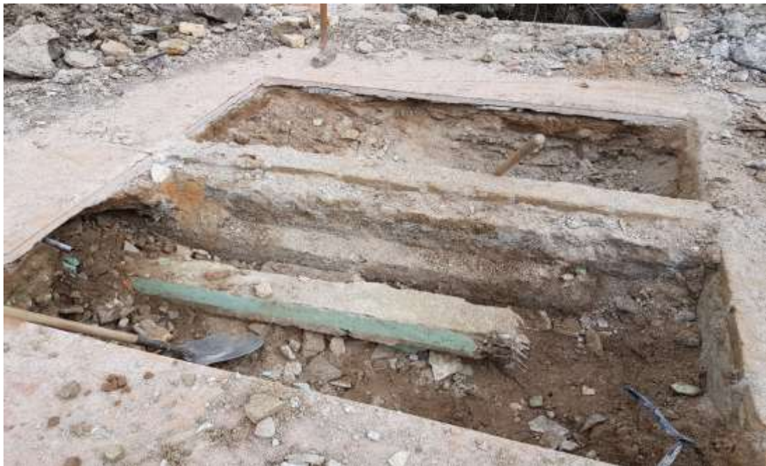
Demolición de piso
