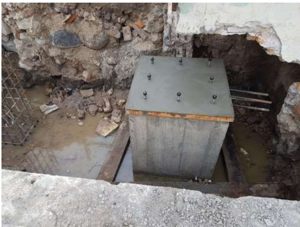
Mortero Autonivelante para Colocación de Placa
