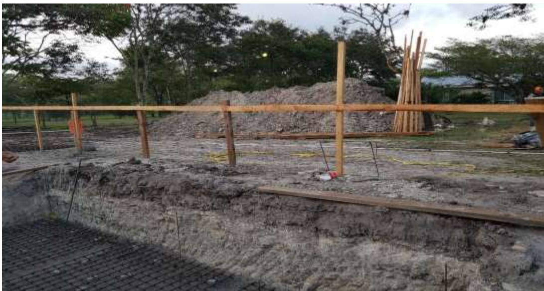
Marcado y Niveleteado
