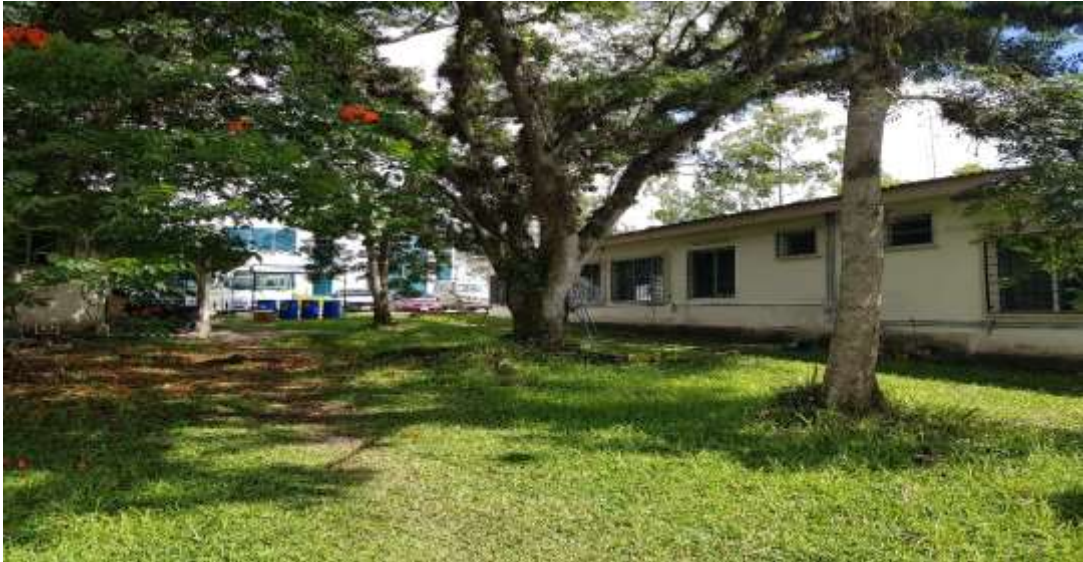
Área de Ampliación
