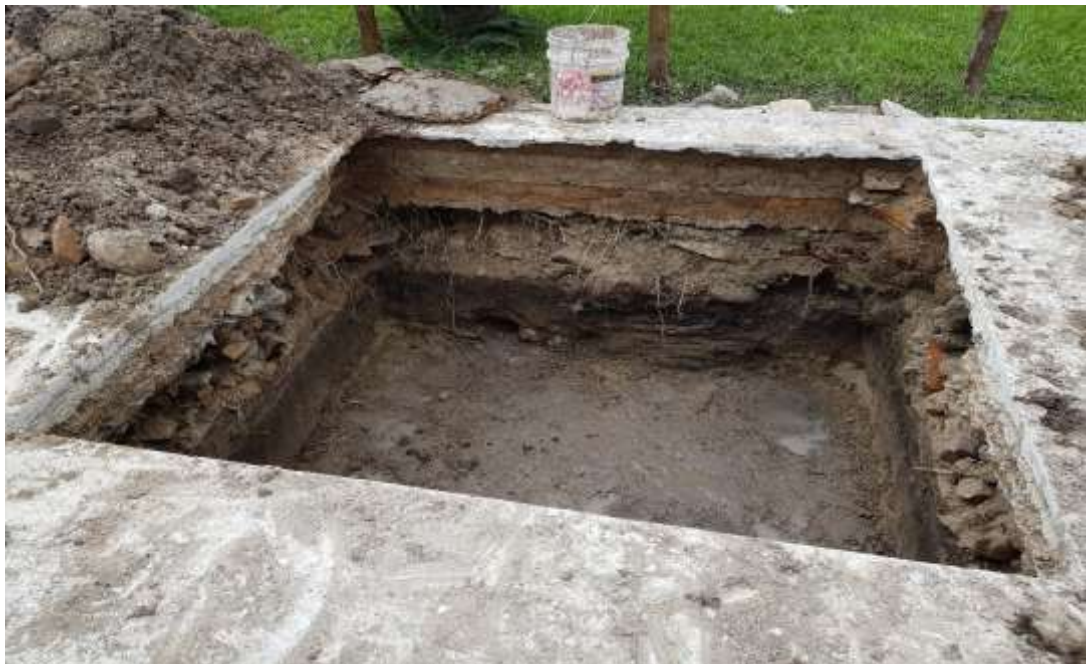
Demolición de piso
