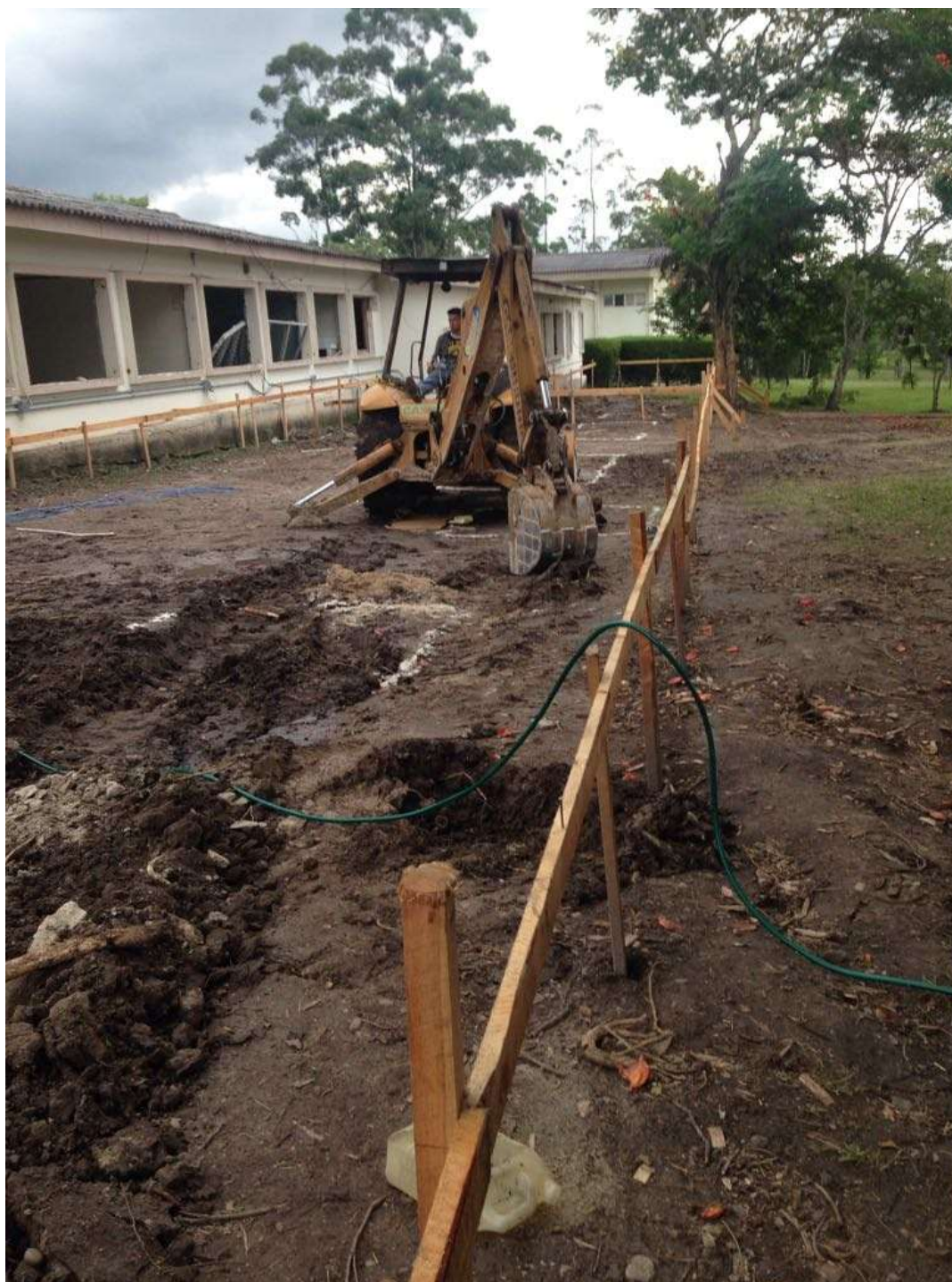
Limpeza del terreno
