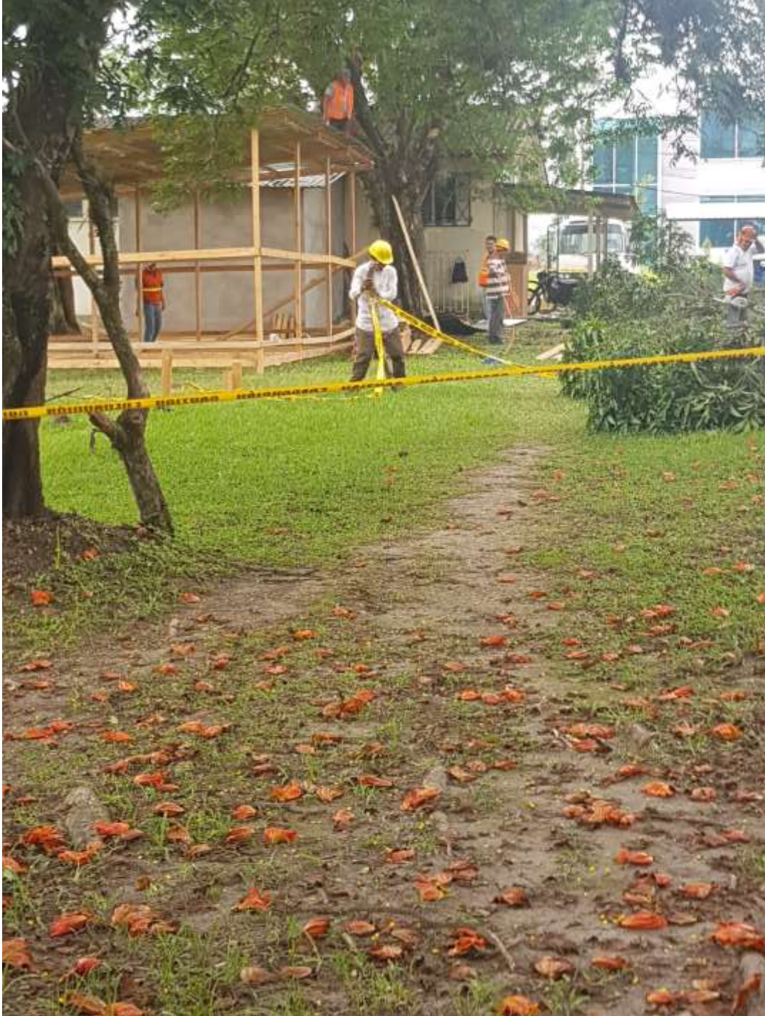
Limpeza del terreno
