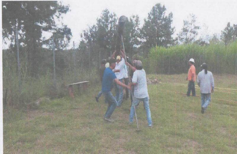
Realizando el incado de los postes de 35 pies para la colocación de Luminarias.
