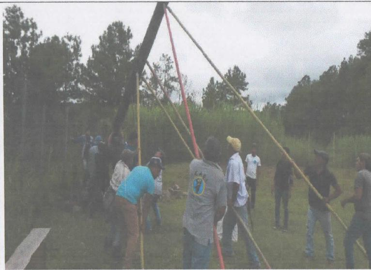
Realizando el incado de los postes de 35 pies para la colocación de Luminarias.
