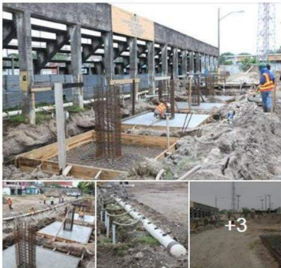
VISITA Y COBERTURA EN LA FUNDICION DE COMIENTO EN LA CANCHA DE BALONCESTO
