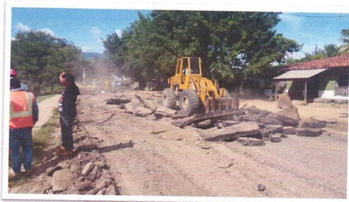
Supervisión de Remodelación de la entrada principal a Guaimaca III etapa.
