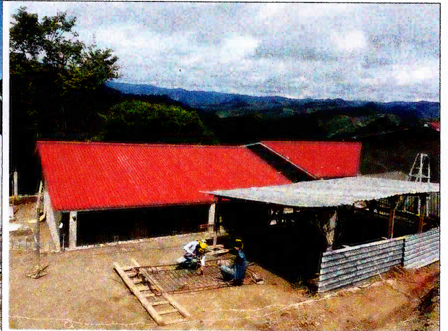
Fabricación de balcones en el sitio con personas de la comunidad.
