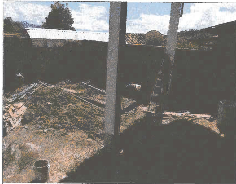
Construccion de modulo de baños y modulo de tuberculosis.
