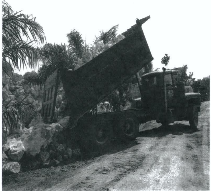
Acarreo de material y depositado en sitio de trabajo
