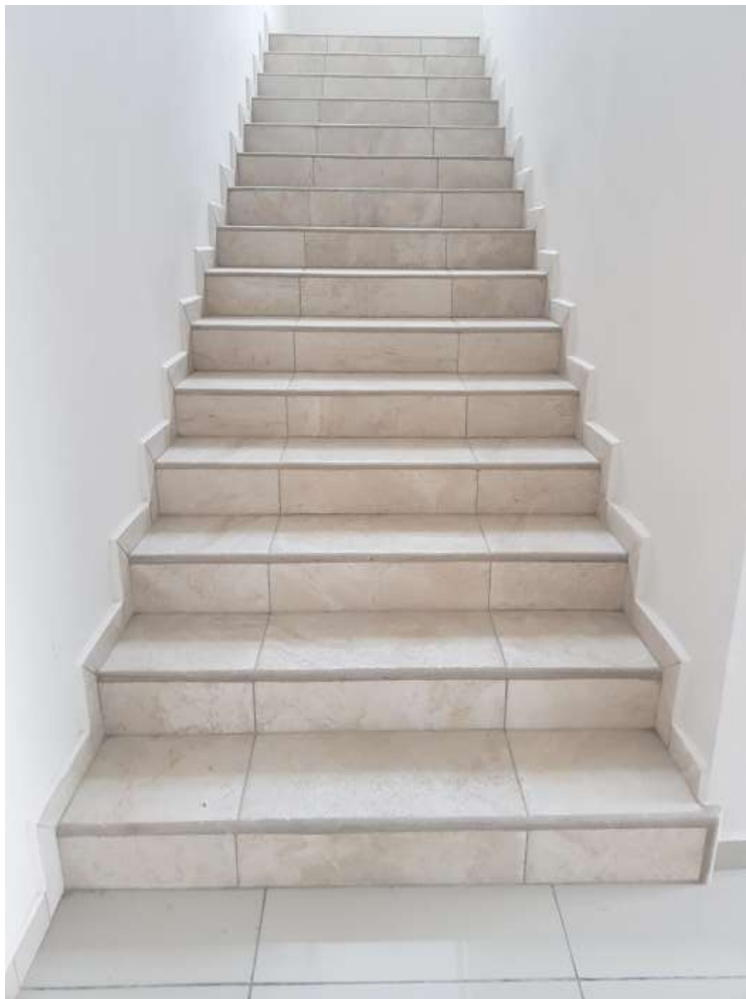
Gradas Estructurales de Concreto
