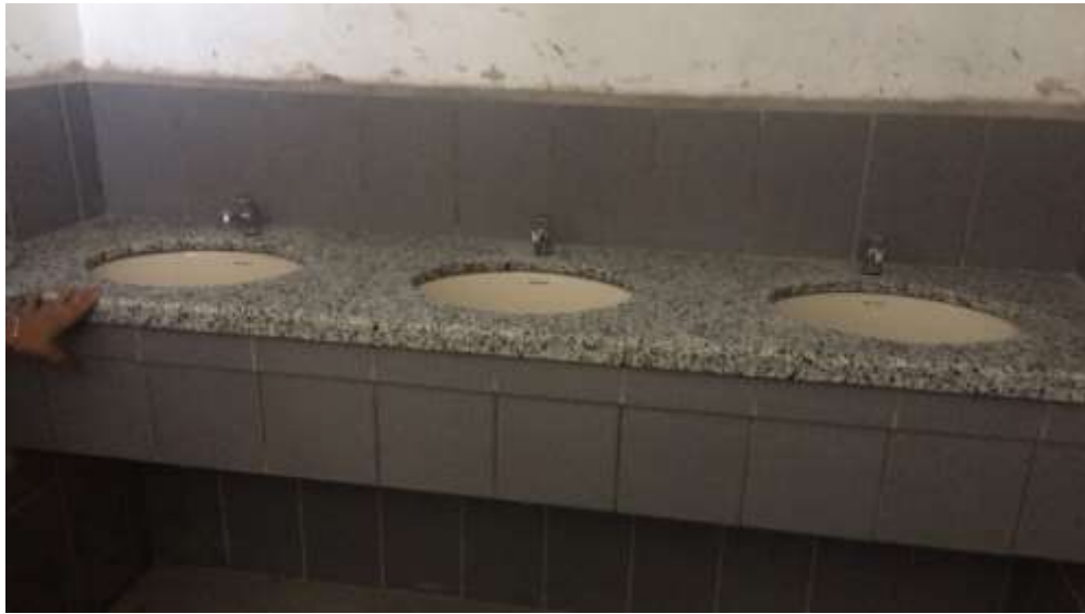
Instalación de Lavamanos Empotrados
