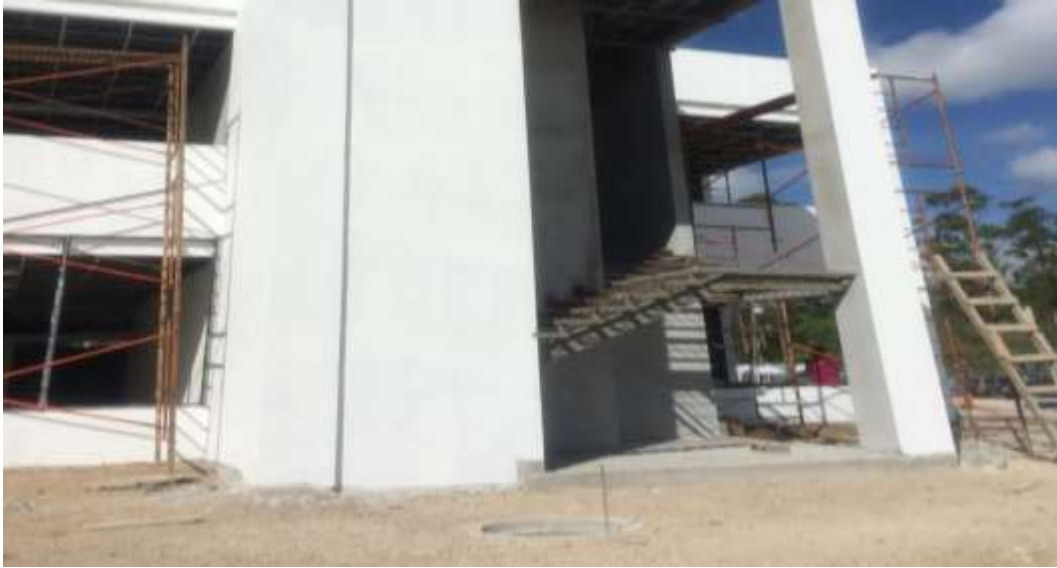
Estructura de Acero en gradass.
