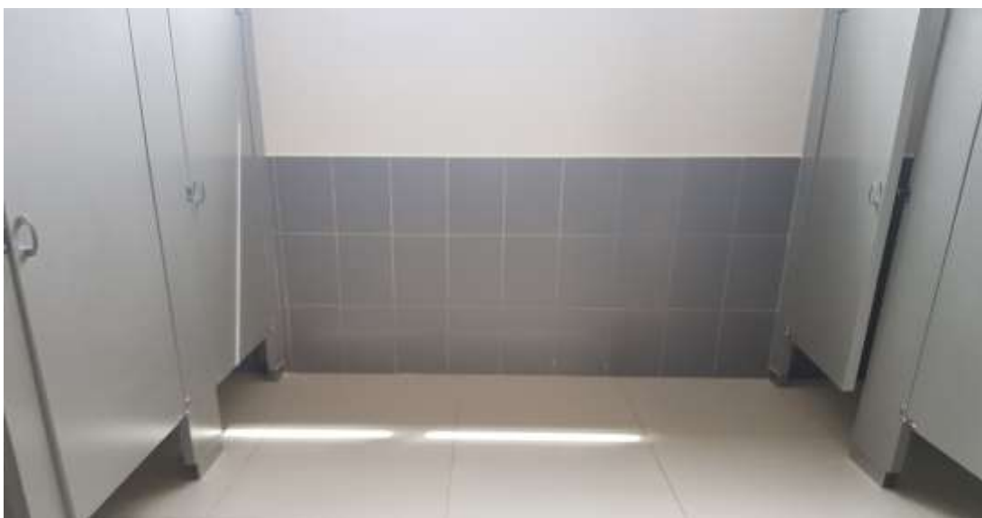
Acabado en Baños
