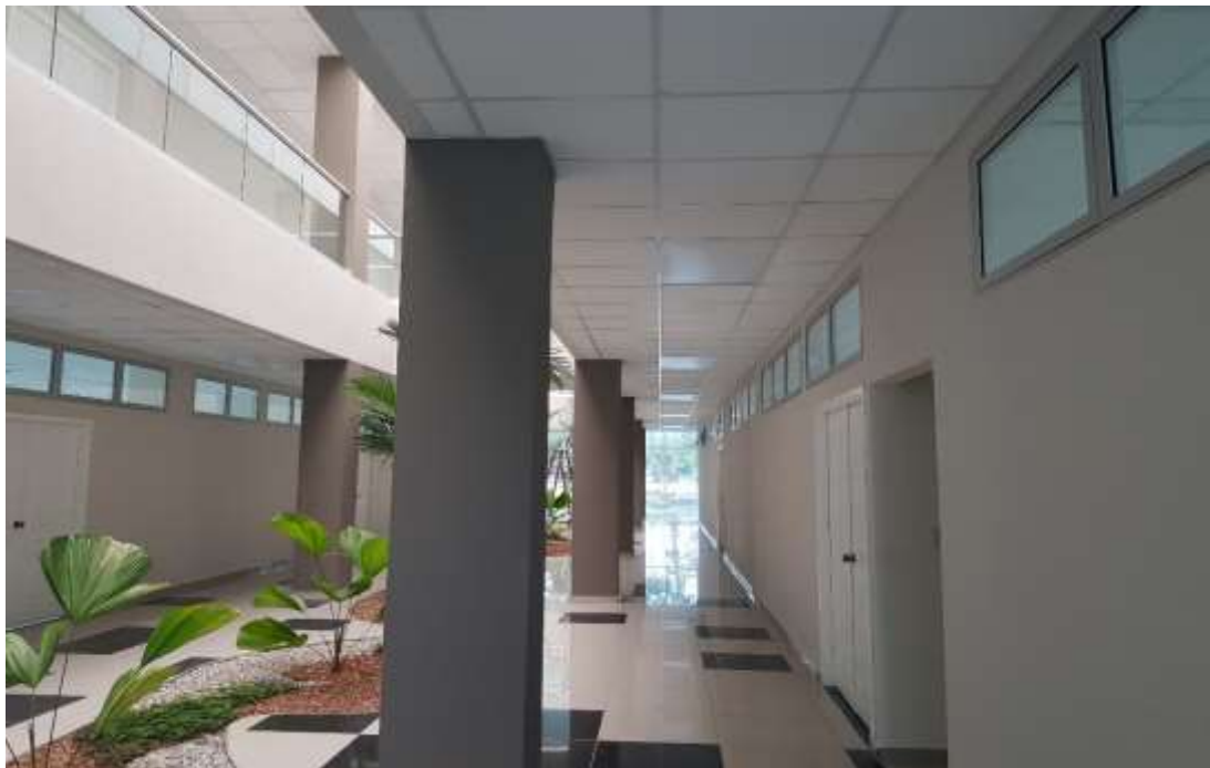
Canaleta de guía de la ductería eléctrica del edificio
