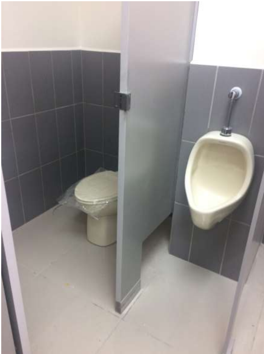
Instalación de Sanitario y Urinario Tipo Fluxometro
