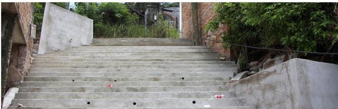
Los trabajos consistieron en obras de terracería, corte, acarreo y colocación de sub base, la reparación de conexiones domiciliarias de agua potable, la construcción de pavimento con concreto hidráulico y muros de contención de concreto reforzado.
