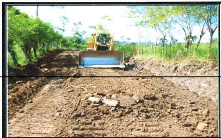
Mecanización de la calzada. Tramo: CA-11-El Florido-El Paraíso
