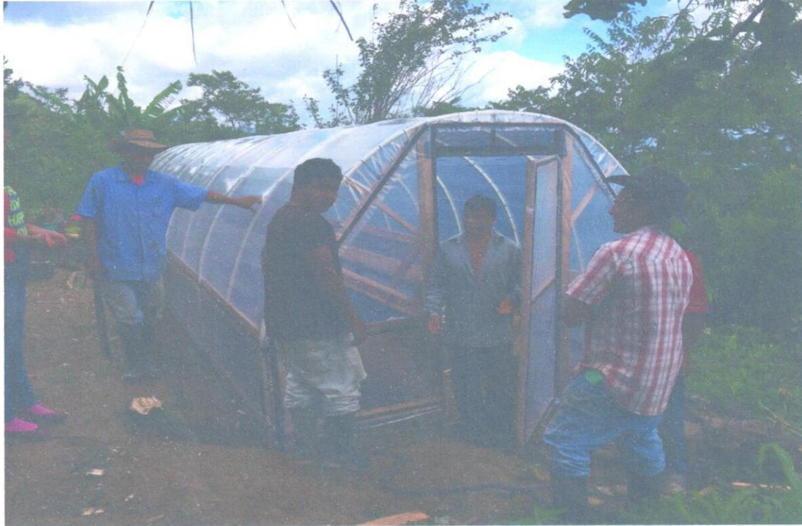
Una vez afianzado el plástico se colocó la puerta; dando por terminada la construcción de la secadora.
