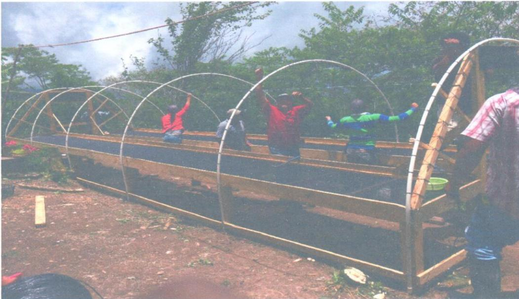
En seguimiento a la construcción procedimos a colocar alambre galvanizado y cabuya de extremo a extremo de la secadora.
