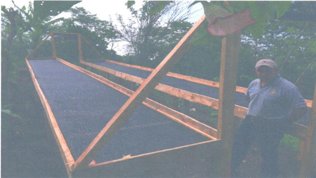
Ing. Olvin Gonzales capacitador de IDECOAS/FHIS inspeccionando que el saran haya sido colocado y tensado como lo requiere el modelo de la secadora.
