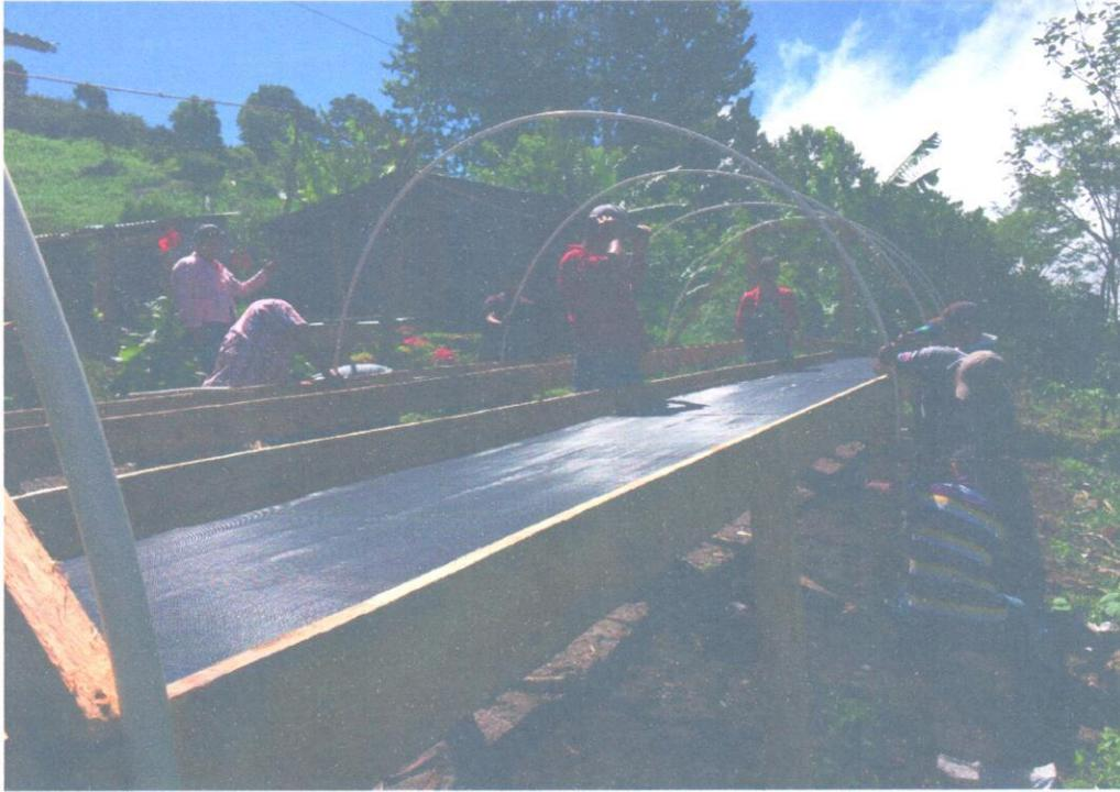
Productores Beneficiarios colocando y afianzando tubería de PVC el cual le dará la forma de domo a la secadora.
