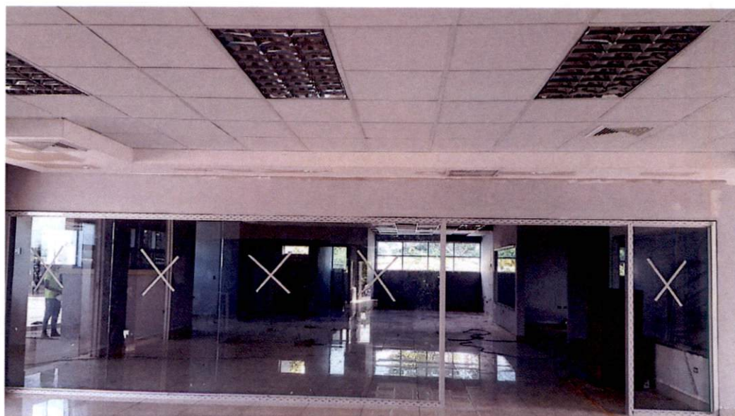
FACHADA DEL EDIFICIO ADMINISTRATIVO.
