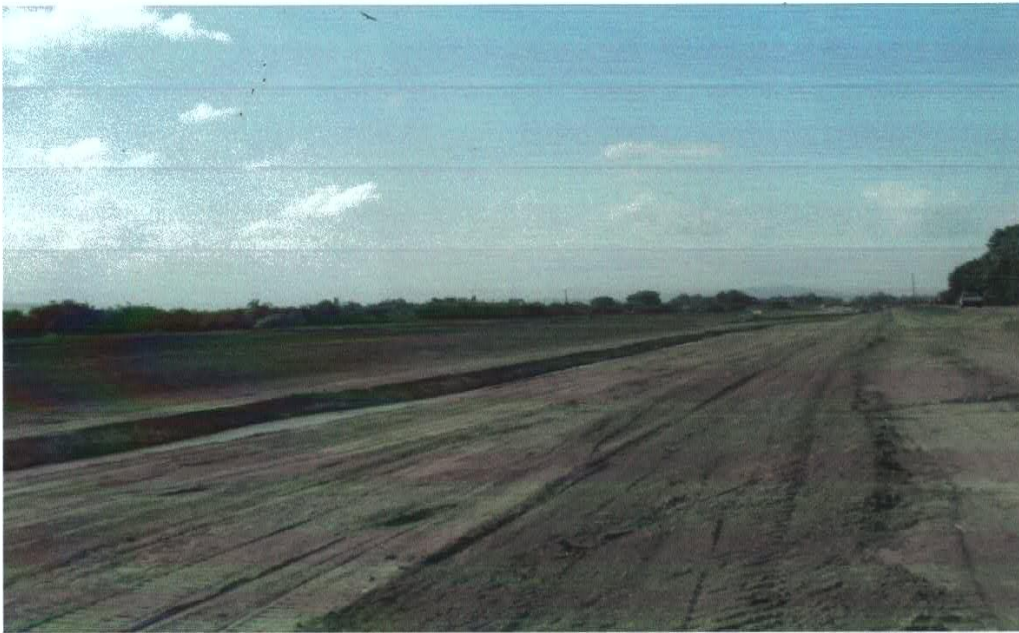
Canal maya agosto 2014 tramo # 5
