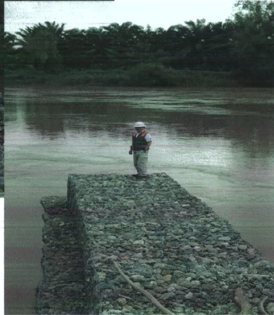
PROYECTO Construcción de espigones de gavión margen izquierda del río Ulúa, Aldea Coco Bolsa, jurisdicción de Choloma, departamento de Cortes, TERMINADO.
