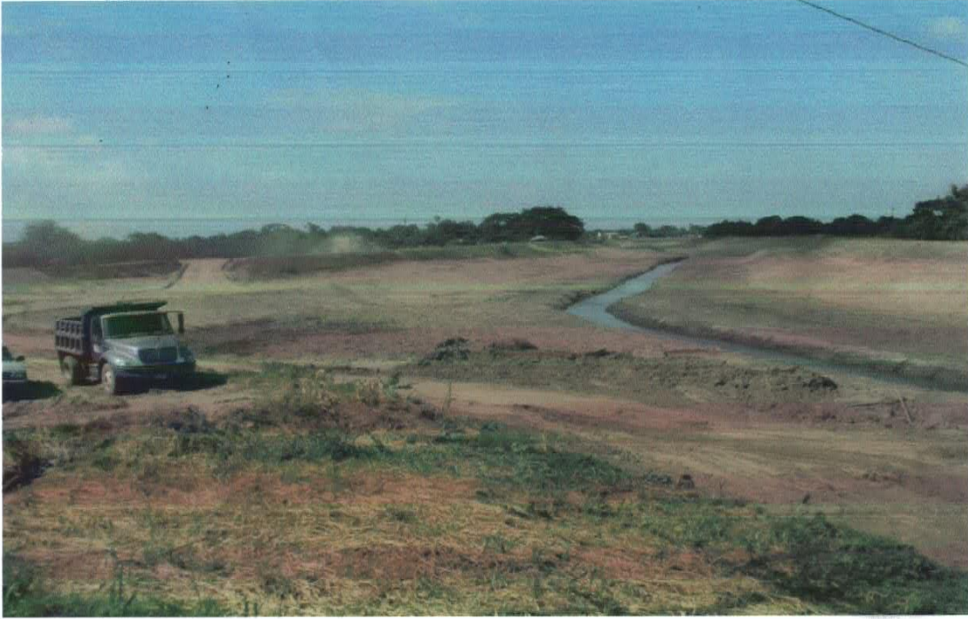
Canal maya agosto 2014 tramo # 6
