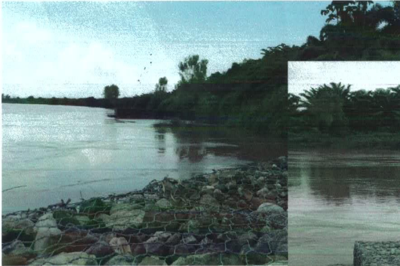
PROYECTO Construcción de espigones de gavión margen izquierda del río Ulúa, Aldea Coco Bolsa, jurisdicción de Choloma, departamento de Cortes, TERMINADO.
