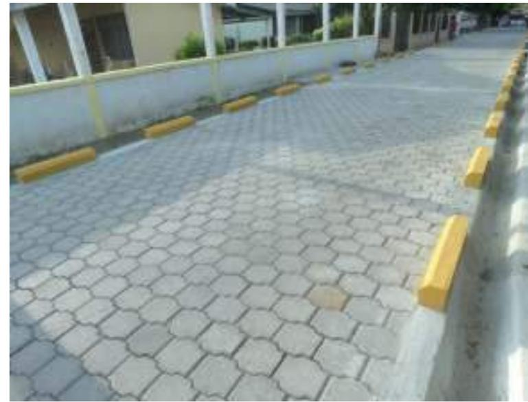
Construcción de empedrado de 172ml, canal parabólico y cruce de calle con alcantarilla de 24", Obra complementaria de construcción de cruce de calle con rieles, bordillos y accesos
