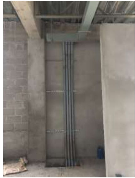
Canaleta de guía de la ductería eléctrica del edificio
