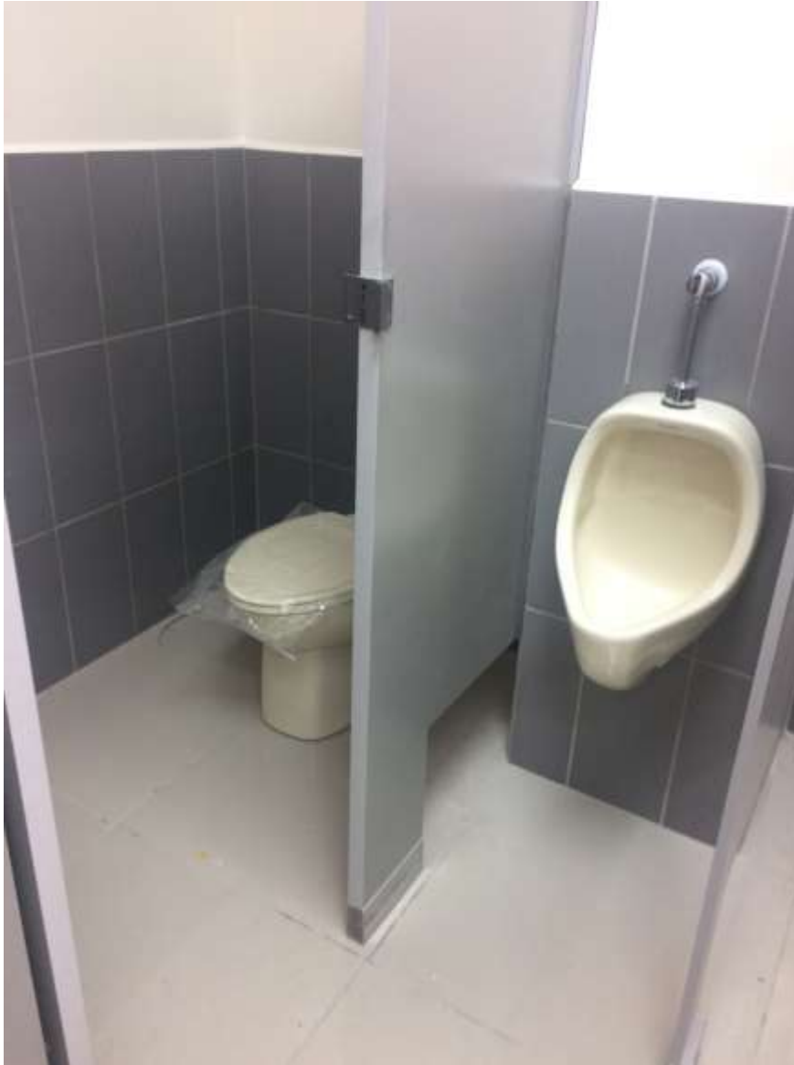
Instalación de Sanitario y Urinario Tipo Fluxometro
