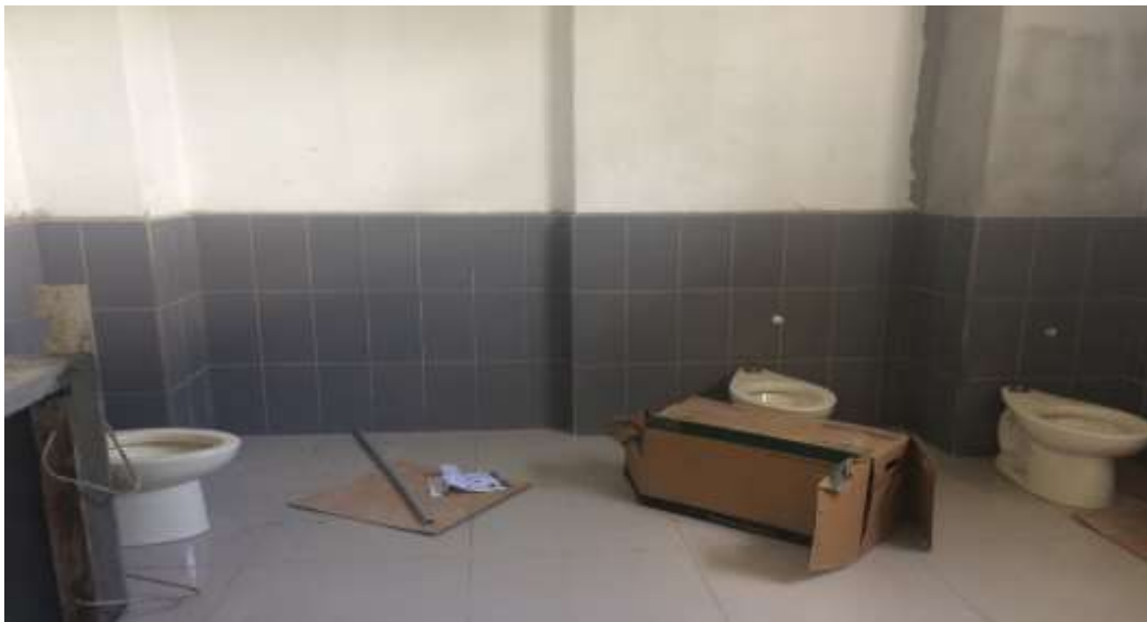
Acabado en Baños
