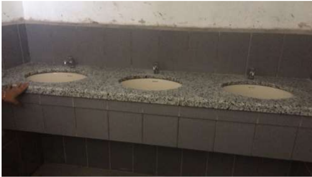
Instalación de Lavamanos Empotrados
