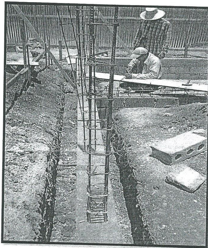
Encofrado de Solera Inferior
