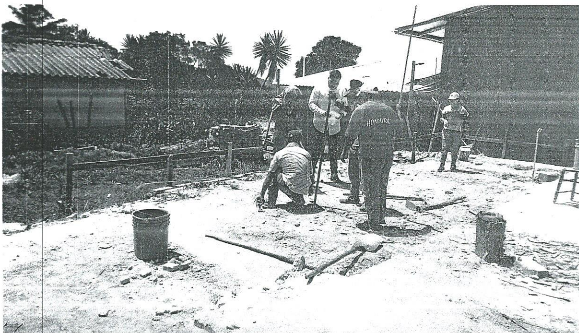
Marcado de dados de concreto y solera inferior
