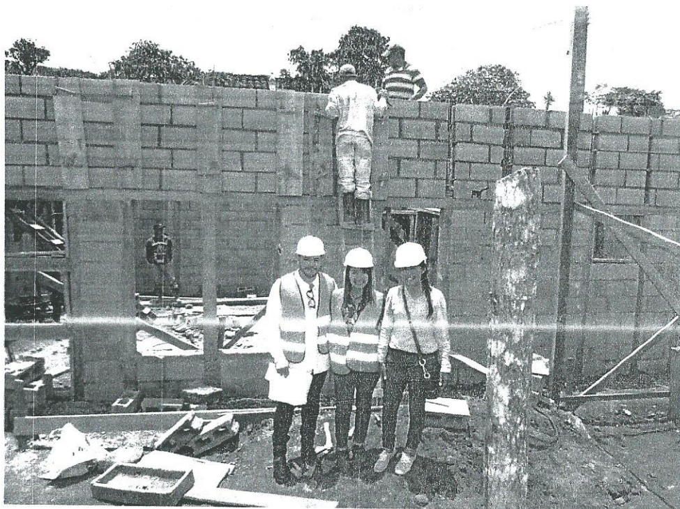
Supervisores de Obra RNP y Contratista
