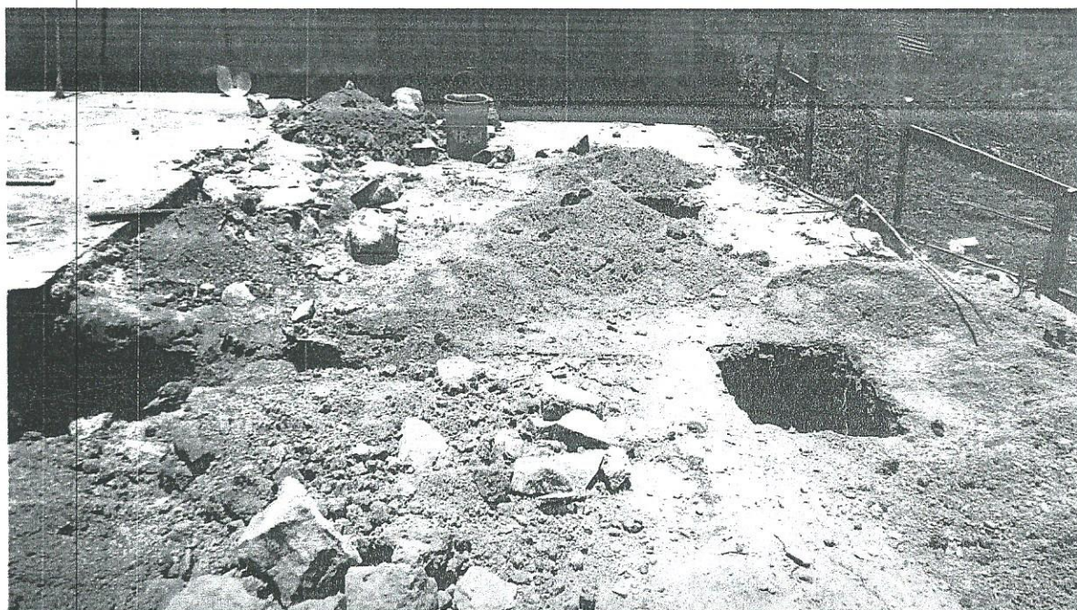
Marcado de dados de concreto y solera inferior
