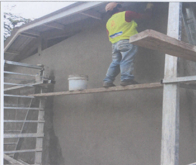
Colocación de la capa de pulido en el módulo de jardín de niños.
