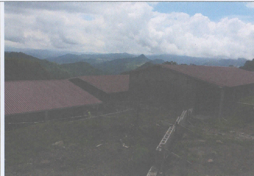
Estructura de techo finalizada en todos los módulos de la edificación.
