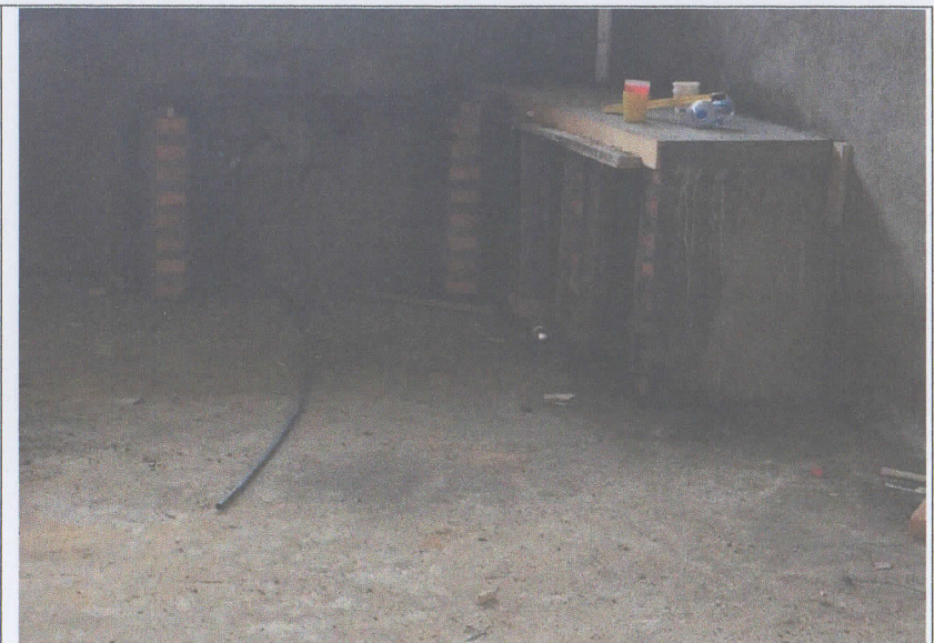
Construcción de muebles de cocina en el módulo de taller Hogar.
