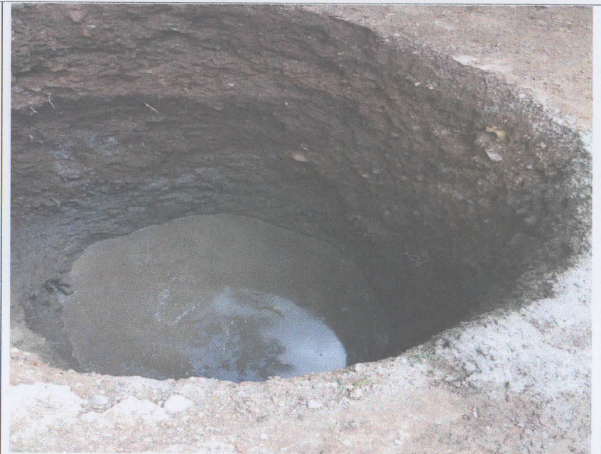
Construcción de pozo de absorción de aguas residuales en el módulo de kínder.
