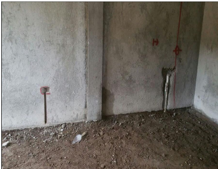
Conformacion del terreno para la fundicion del firme de concreto
