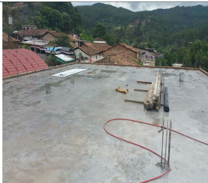
Losa aligerada fundida con un espesor de 10 cm.
