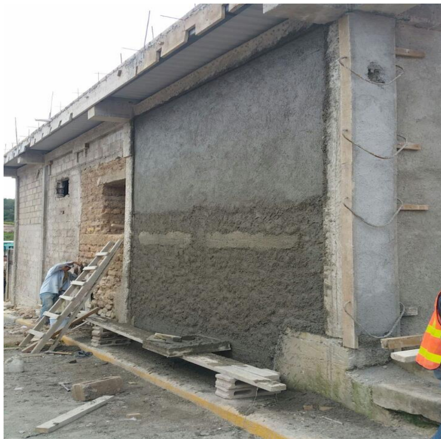
Finalizacion del repello en paredes exteriores
