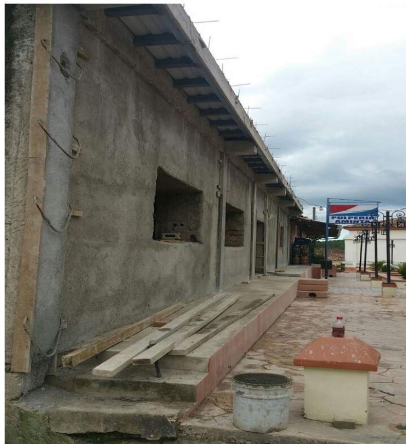
Repello en pared frontal finalizado
