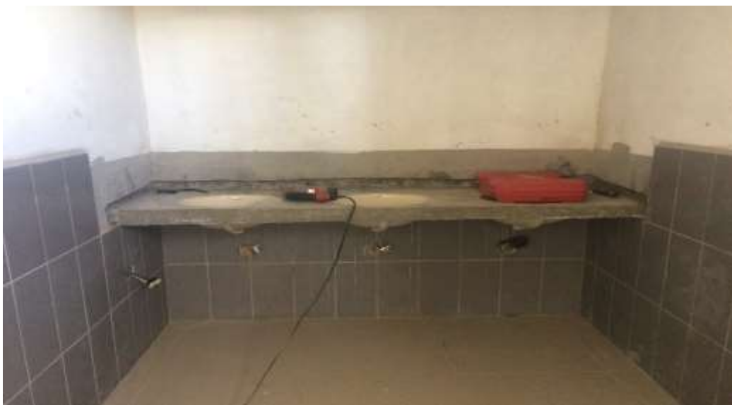
Instalación de Lavamanos Empotrados
