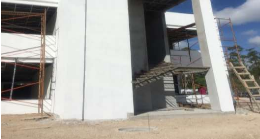
Estructura de Acero en gradass.
