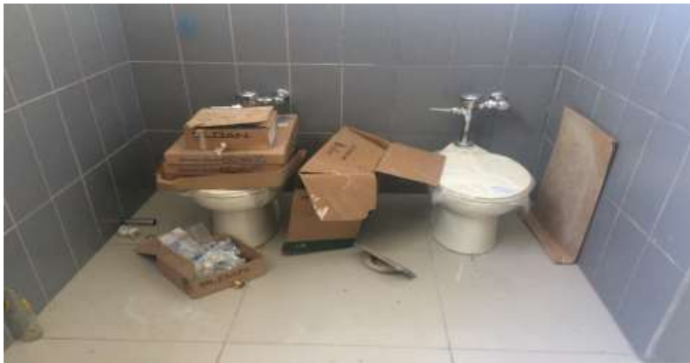
Instalación de Sanitario Tipo Fluxometro
