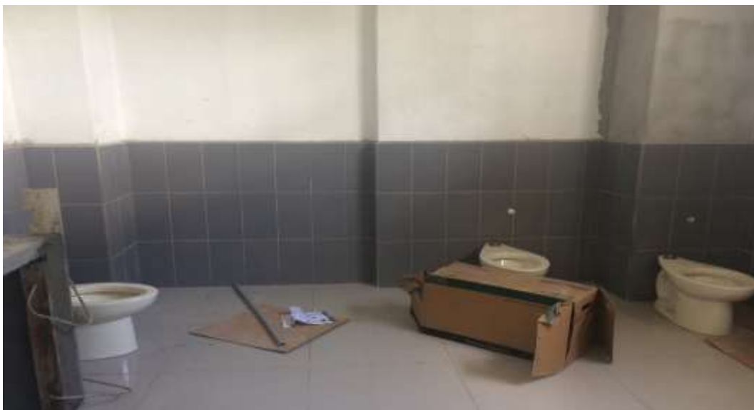
Acabado en Baños
