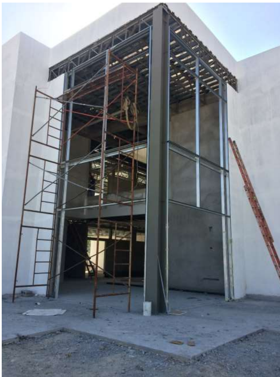
Instalación de Perfilería de aluminio.
