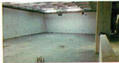
Instalación de piso nivelante previo a instalación de acabado final
