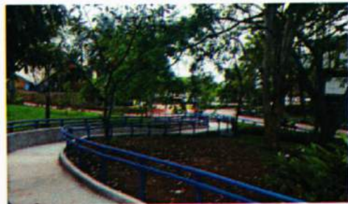
Vista de rampa terminada, para personas con discapacidad; conduce hacia el Edificio A1
