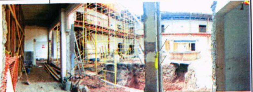
Se ha terminado la excavación de la cisterna y se trabaja en el resto de las excavaciones estructurales en el ala norte del Proyecto
