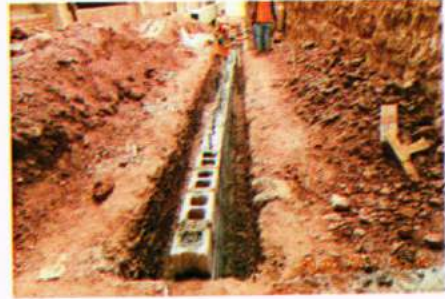
Sobrecimiento de rampa en plaza norte
