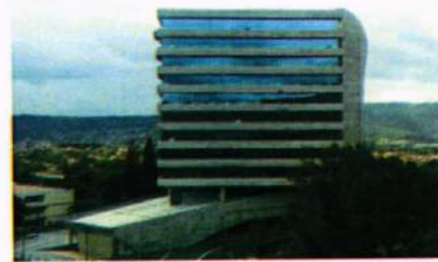
Vista sur-este del edificio.
