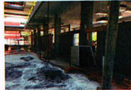
Levantamiento de paredes de bloque en el Nivel 1.
