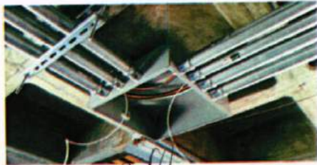
Avance de instalación de cableado
