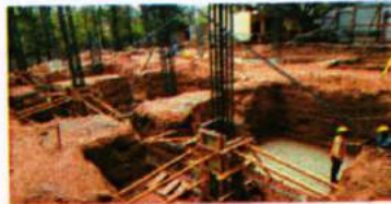
Encofrado de zapata corrida
