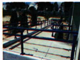
Construcción de rampa de acceso
