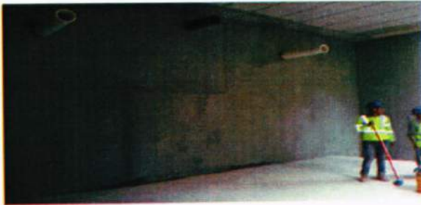
TUBERIAS PVC 8" DE INGRESO DE AGUA A LA NUEVA CISTERNA
