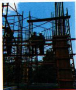
Vista de encofrado de columnas entre nivel 0:+0.00 y nivel 1:+4.00; 18- 05-2017)
