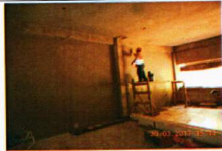
Pulido premezclado en paredes aligeradas
