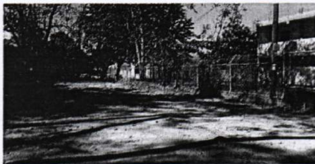
SITIO DE CONSTRUCCION DE MURO PERIMETRAL
