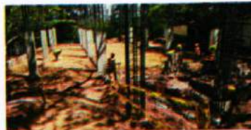
Se observa columnas fundidas del nivel de sótano
