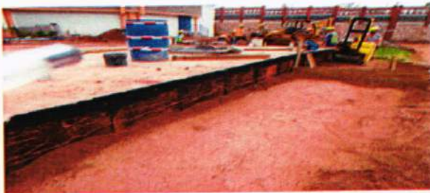
RELLENO Y COMPACTACION AL CONTORNO EXTERNO DE LAS PAREDES DE LA CISTERNA
