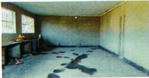
Vista de firme de concreto, repello y pulido terminado en área de manejo de huevos (19-05-2017)
