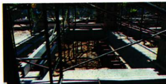
Vista de Vigas nivel 0:+0.00 y columnas entre nivel 0:+0.00 y nivel 1:+4.00; 23-05-2017
