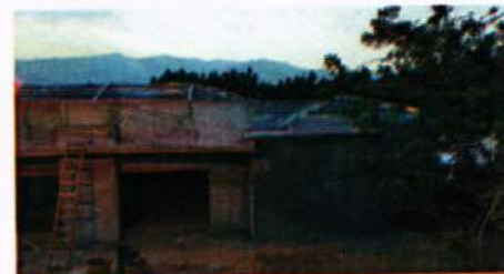
Fachada posterior planta piloto, UNAH-TEC-AGUAN
