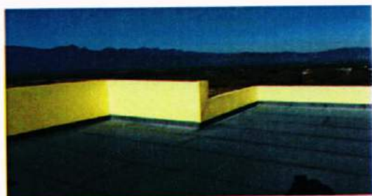
Vista de la impermeabilización terminada de la azotea 2, en Edificio Principal del CURC
