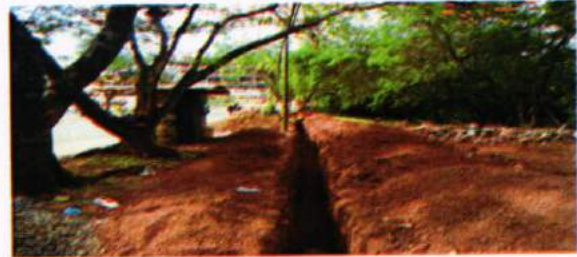
EXCAVACION DE ZANJO PARA INSTALAR TUBERIA PVC SDR-26 PARA SUMINISTRAR AGUA A LA CISTERNA DE LA FACULTAD DE ODONTOLOGIA
