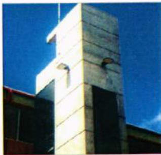
Vista de cubo de elevador terminado con sus reflectores, Edificio A2
