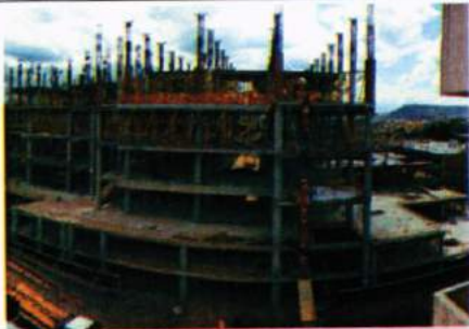
Vista este del avance de la estructura del edificio.
