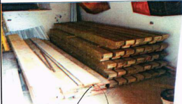
Se han entregado al Proyecto al rededor de 7,000.00 pie tablar para la estructura de techo
