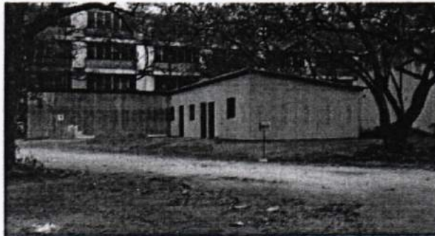
OFICINAS Y BODEGAS DE CAMPO
