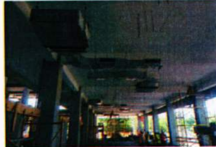
Instalación de máquinas evaporadoras en el Nivel 1.
