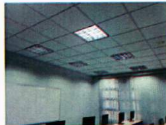
Instalación de cielo falso
