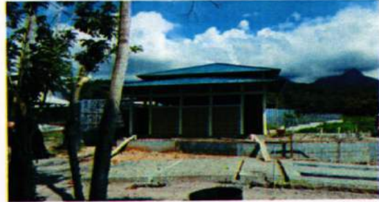
Vista de fachada Norte módulo de desinfección personal (19-05-2017)
