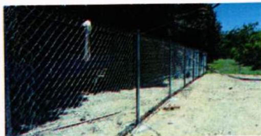
Vista de cerco perimetral de malla ciclon; 23-05-2017
