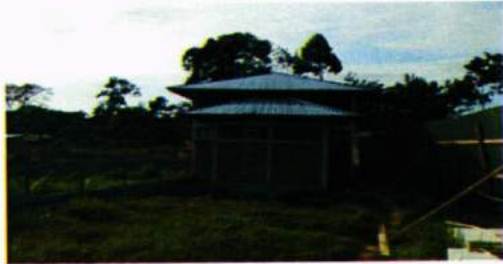
Vista de fachada Sur módulo de desinfección personal (19-05-2017)
