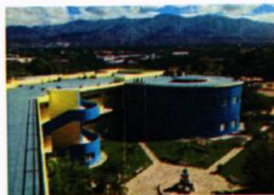
Vista de la impermeabilización terminada en azotea 1, a la derecha área ejes 21 al 28
