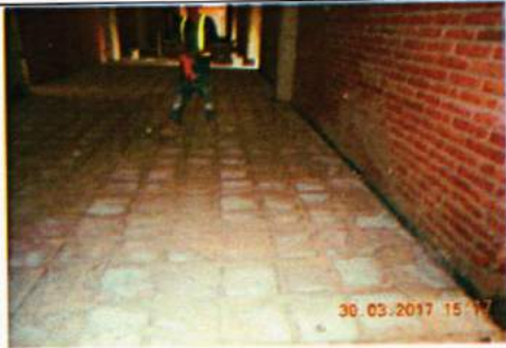
Fraguado de piso de granito
