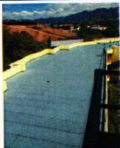
Vista de la impermeabilización terminada en azotea 1
