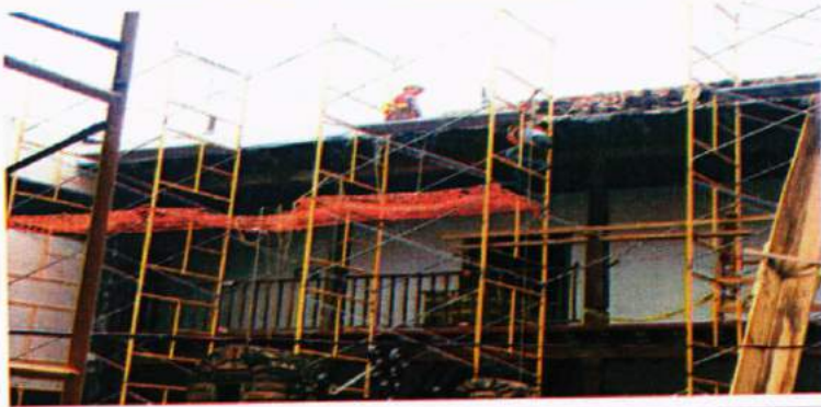
Se continua con el desmontaje de la teja
