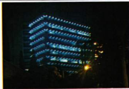
Vista oeste del edificio.
