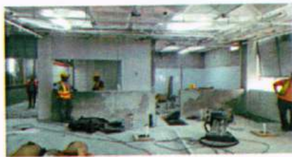
Instalación de paredes de tablayeso
