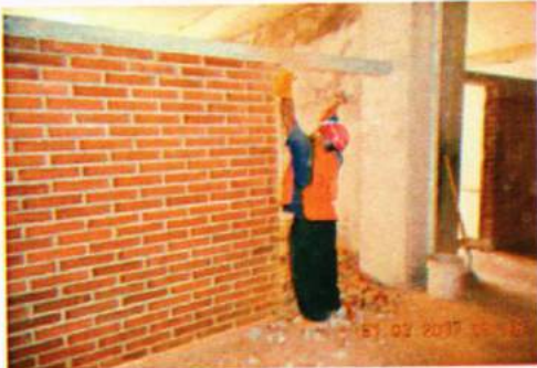
Demolición de boquete para vestíbulo de aulas
