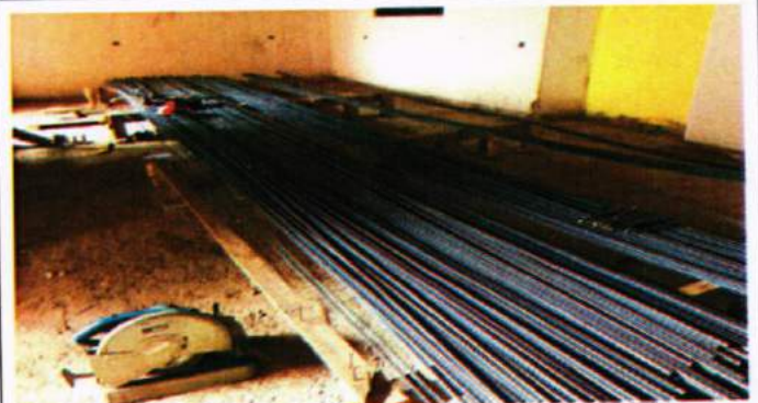
Se cuenta con el hierro para la cisterna y cimientos. Se esta trabajando en su armado
