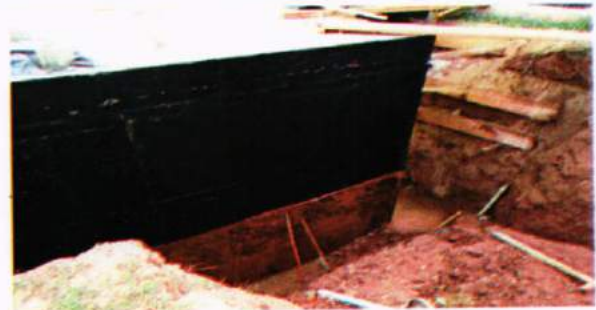
PINTADO CON IGOL DENSO PARTE EXTERNA DE PARED DE CISTERNA PARA PROTEGERLA DE AGUAS AGRESIVAS, SALINAS Y ACIDAS
