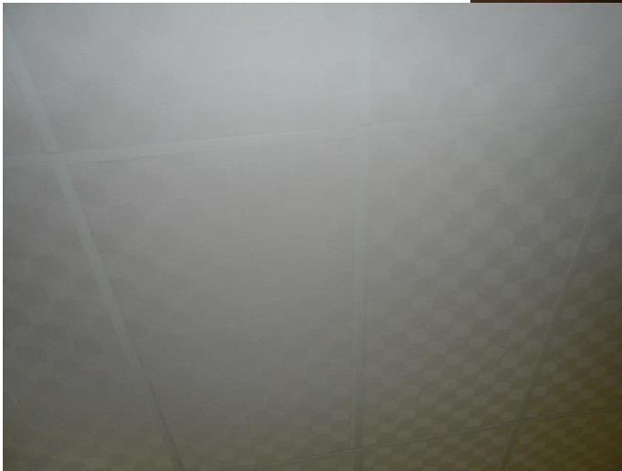
Cielo falso ya puesto
