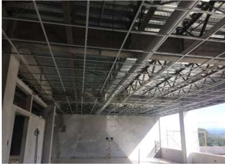
Estructura para cielo
