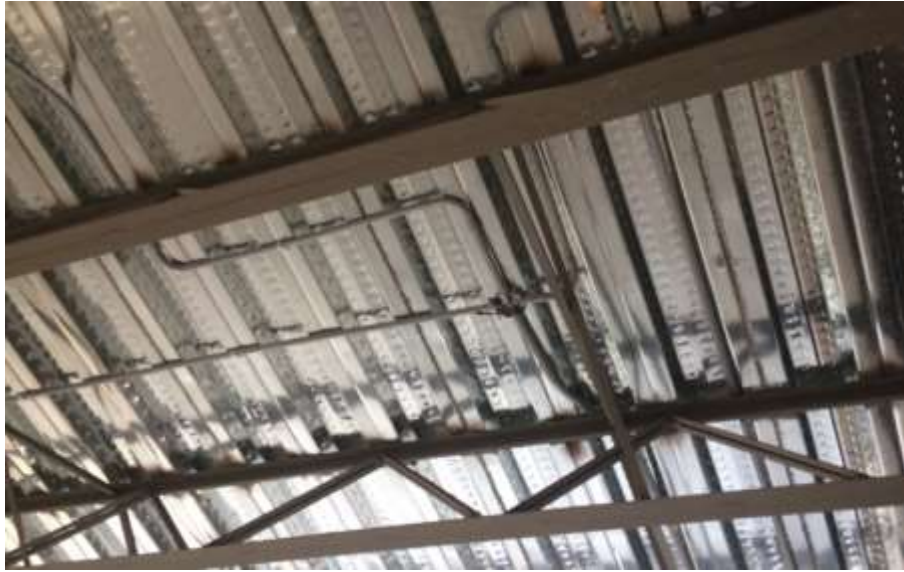
Salidas eléctricas para lamparas de 2x4
