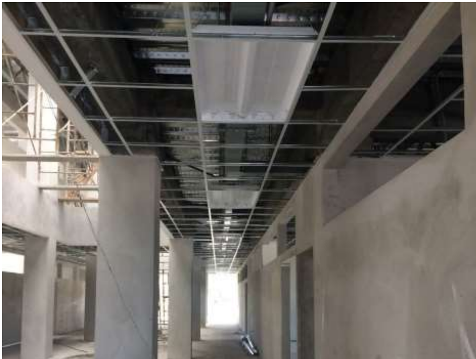
Estructura para cielo
