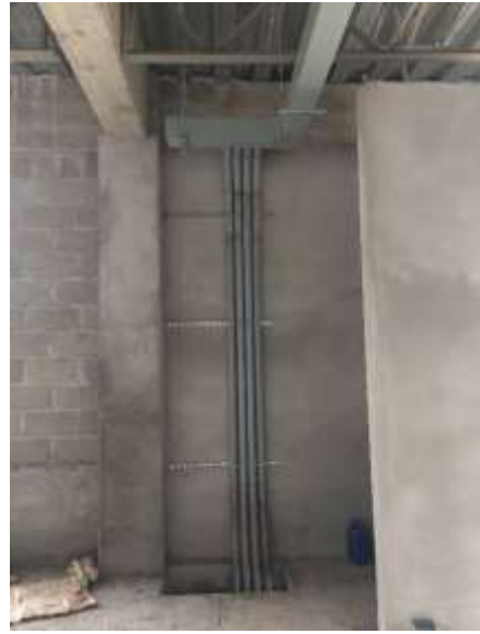
Canal de guía de la ductería eléctrica del edificio
