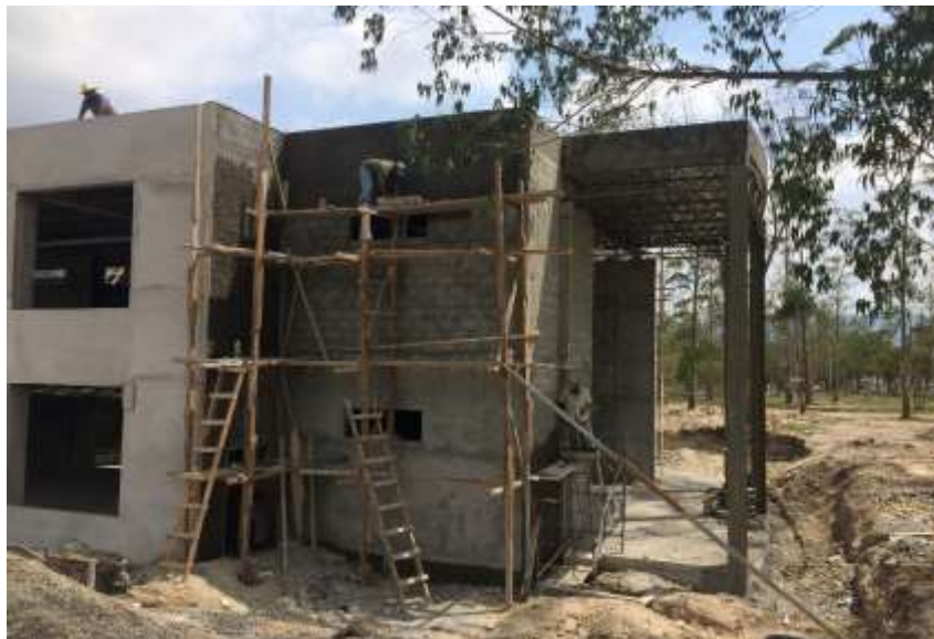
Colocación de bloque de 4" con bastoneado, fundido con concreto 2500PSI
