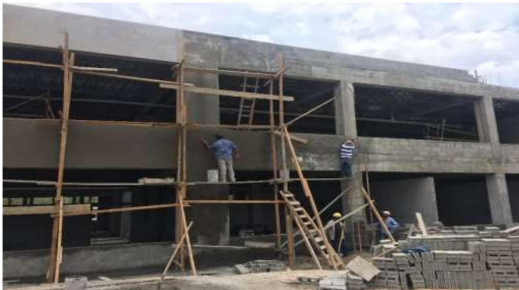
Tallado de Elementos Estructurales
