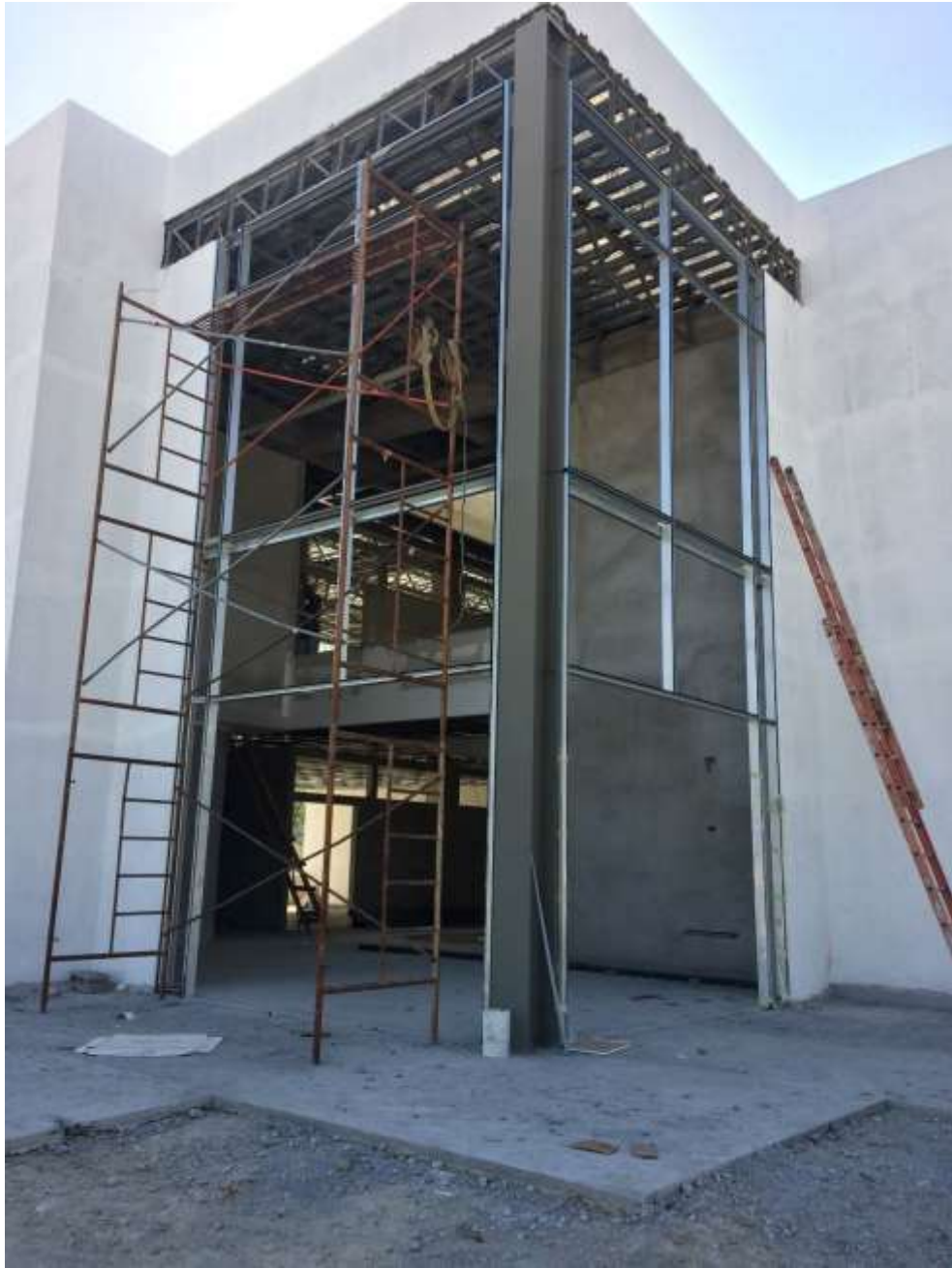
Instalación de Perfilería de aluminio.
