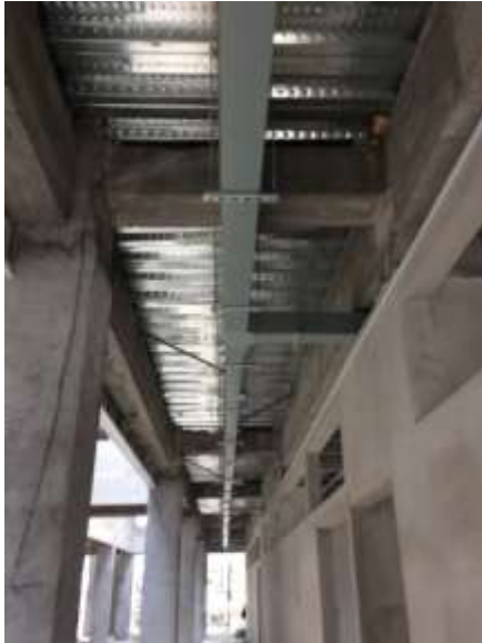
Canal de guía de la ductería eléctrica del edificio
