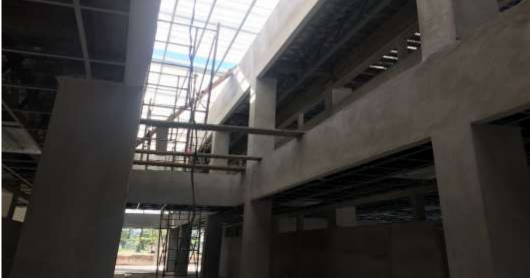
Tallado de Elementos Estructurales
