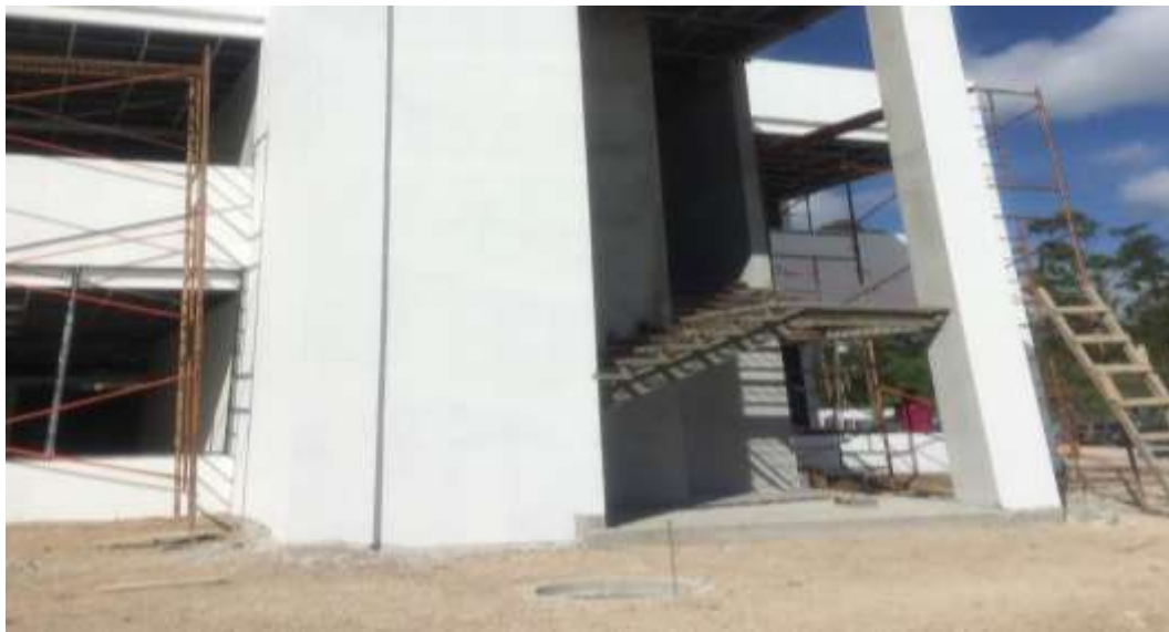
Estructura de Acero en gradass.
