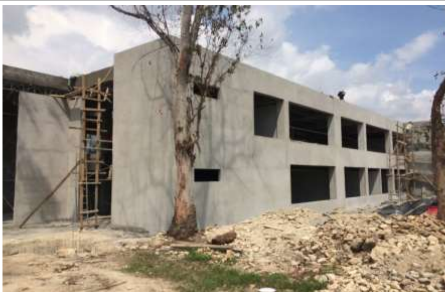
Colocación de bloque de 4" Terminada
