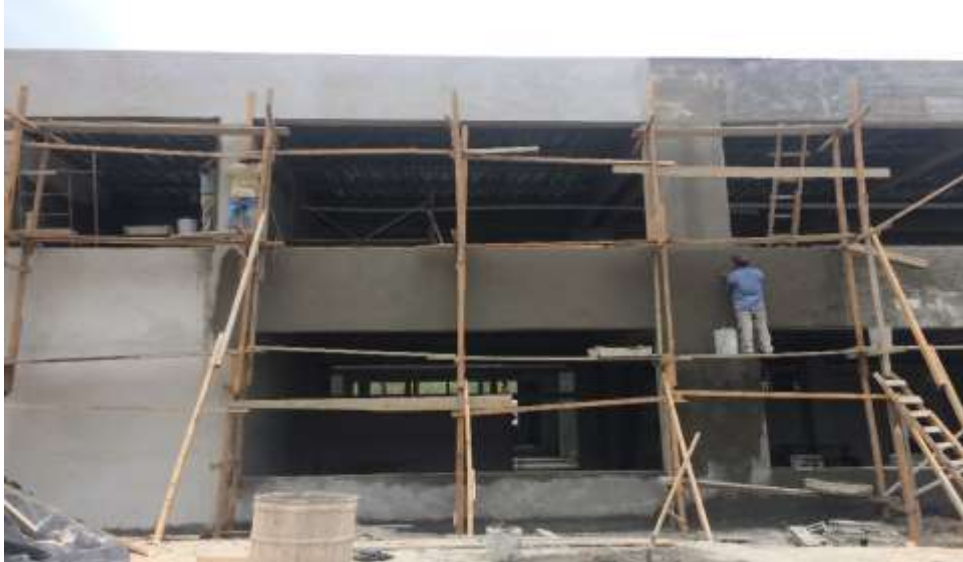
Repello en Paredes
