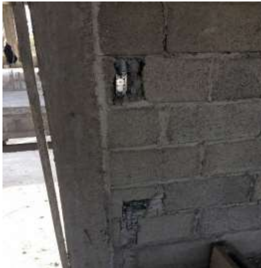
Salidas eléctricas para interruptores
