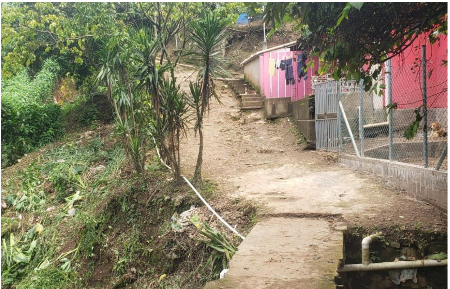
vista de la carretera de acceso
