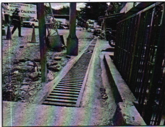
Instalación de rejilla en cuneta
