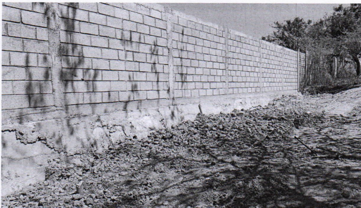
Construcción del muro perimetral del TRAMO B
