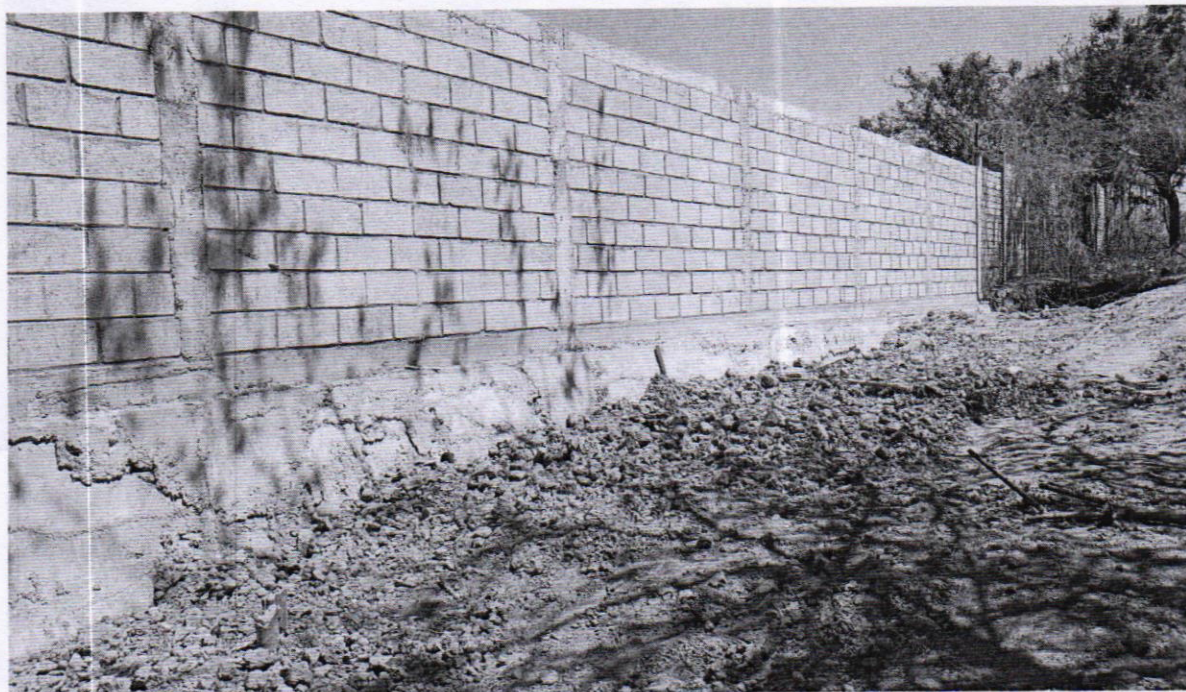
Actividad de relleno y compactado en el Tramo A
