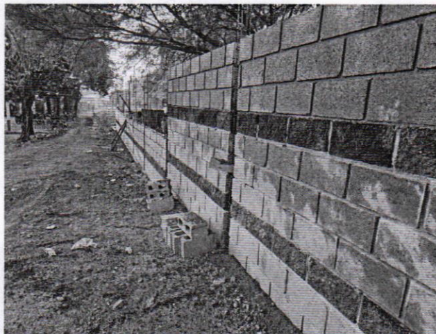
Muro perimetral – Aduana Guasaule
