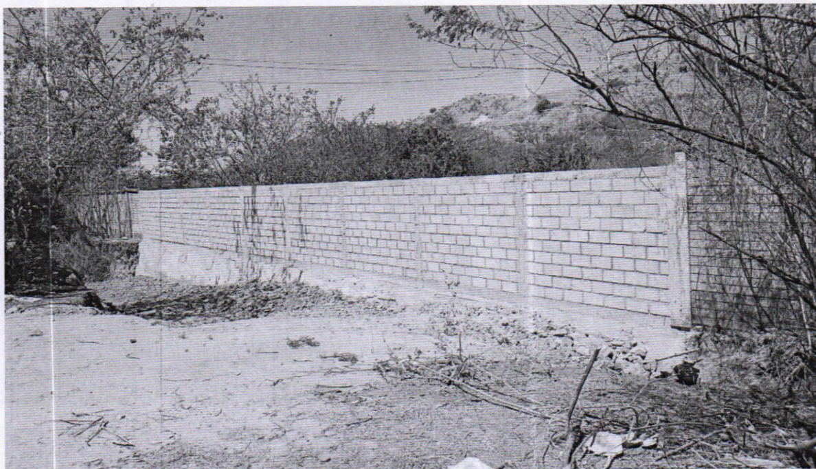
Construcción de tramo del muro perimetral del TRAMO A.
