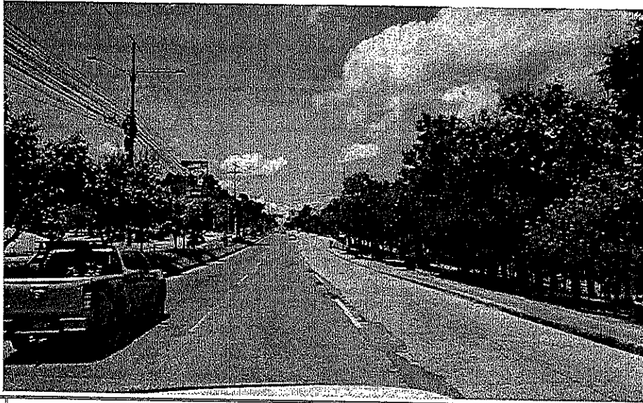
No.7 Actividad: Vista del Anillo Periférico tramo 2
