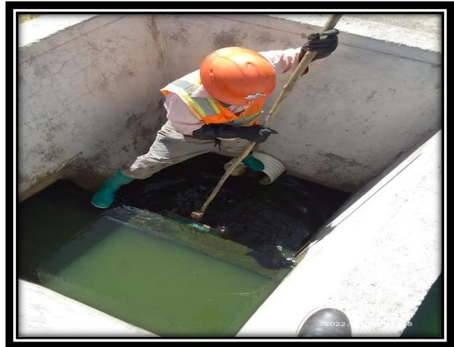
RESULTADO; El Operador realiza los mantenimientos en La Planta esto lo hace en los Reactores, en el Filtro Anaerobio y en Las Lagunas de Pulimiento.
