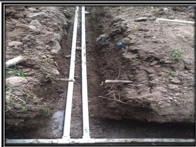
**RESULTADO:**Durante el trabajo se hizo la instalacion de tuberia de 1", ademas de las conexiones domiciliarias y las respectivas cajas y sus medidores por cada usuario.
