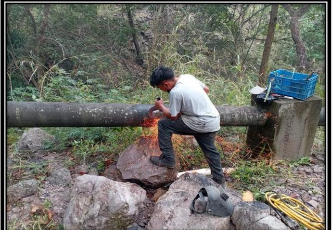
DESCRIPCION: Se tuvo un daño en la tubería de HFD de 12" en La línea de Conduccion principal en el sector del Zapote, se desplazo equipo de Operación y Mantenimiento y al contratista para la realizacion de dicha actividad.
