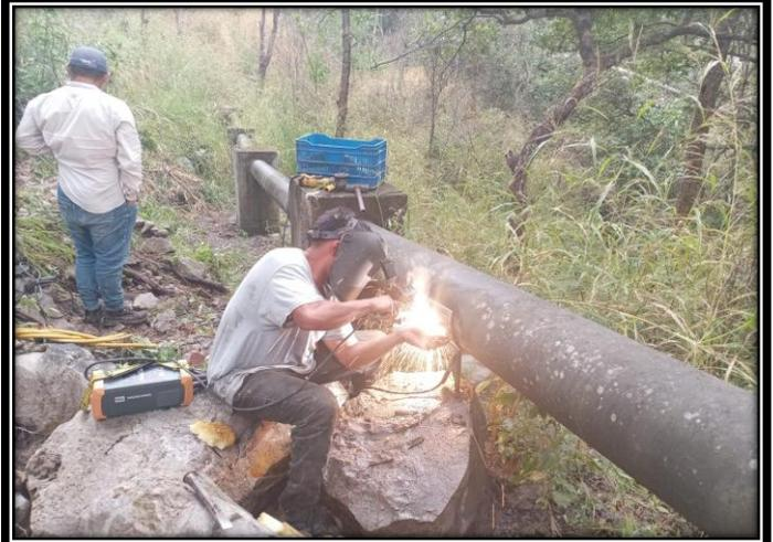
RESULTADO: Al llegar al sitio se comprobo que una roca golpeo la tubería lo que provovo que la misma se dañara , se procedio a la soldadura de la misma con un electrodo NIQUEL 99 para poder reestablecer el servicio.
