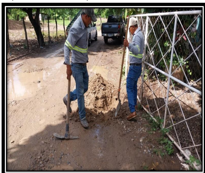
Inspecciones reducción de pérdidas.
