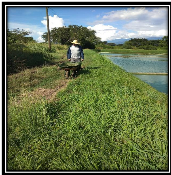
Mantenimiento en La Planta de Aguas Residuales
