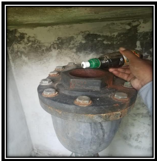
Mantenimiento de Válvulas de aire
