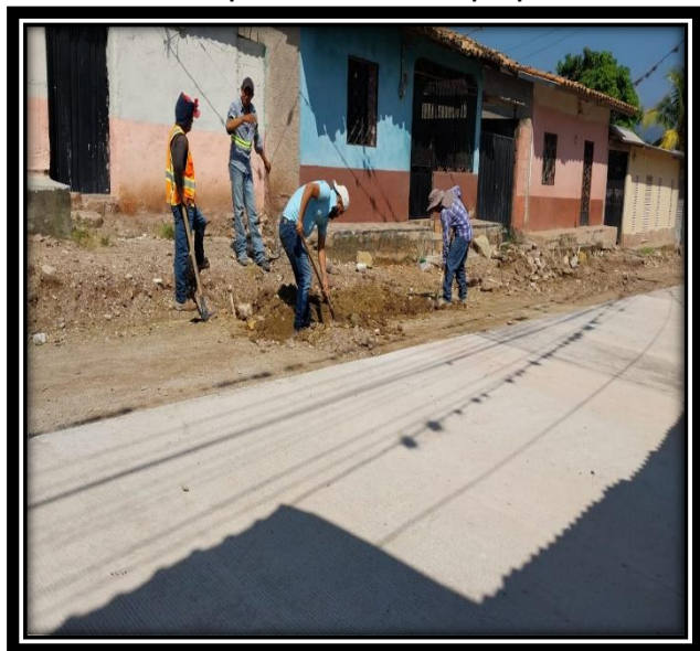
Reparación de tuberías por pavimentos
