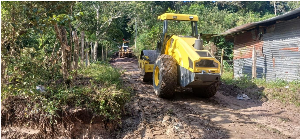
Motoniveladora y vibro compactador en escarificado, conformación, cuneteo y vibrado de calles en aldea Los Pozos.
