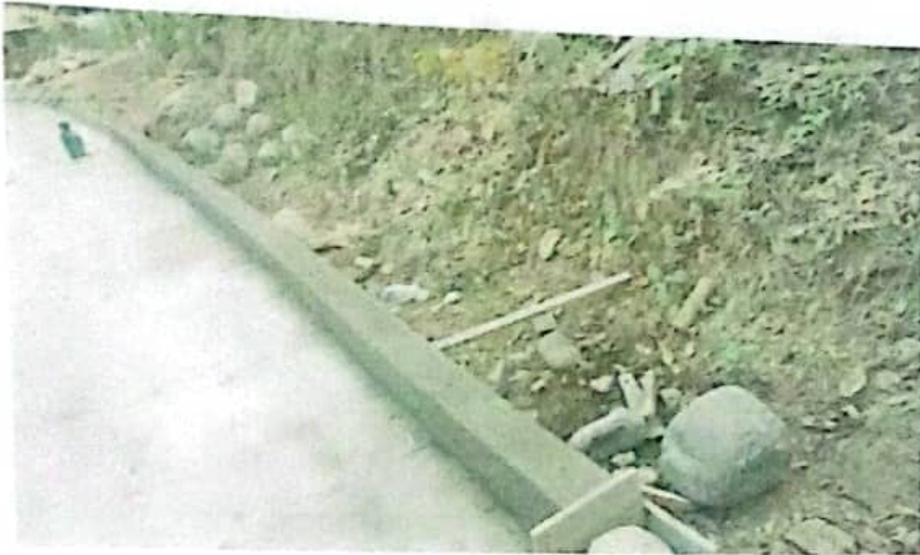
*Construcción de Bordillo de concreto en calzada de pavimento ciclópeo*
