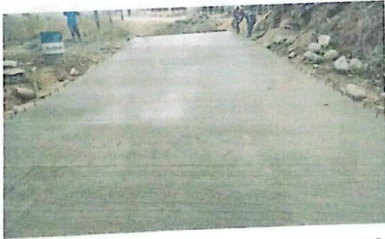
*Fundición de pavimento de concreto ciclópeo sobre la base conformada, acabado final de superficie de calzada.*
