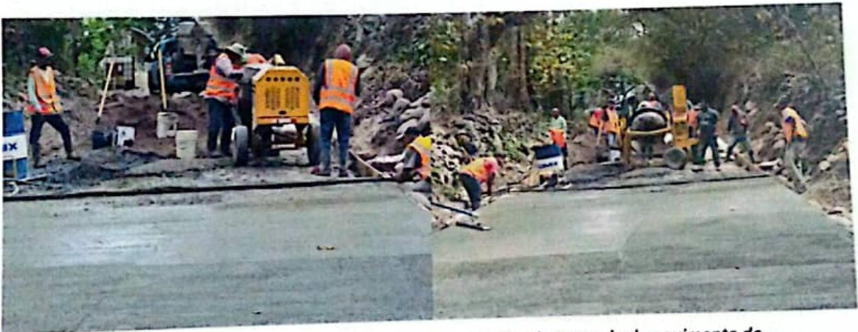
*Fundición de pavimento con concreto ciclópeo, vibrado y afinado y curado de pavimento de concreto hidráulico*
