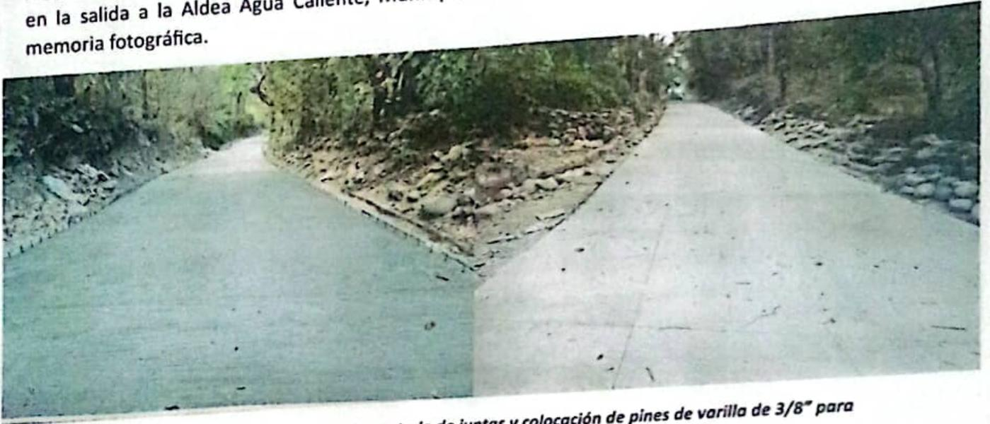
*Fundición de Concreto Ciclópeo, rastrillado, cortado de juntas y colocación de pines de varilla de 3/8" para posteriormente ejecutar actividades de construcción de bordillos de concreto.*
