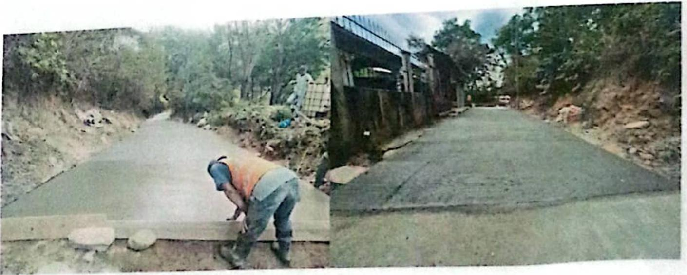
*Fundición de Concreto Ciclópeo, afinado de losa de concreto para posteriormente cortar juntas y colocar pines de varilla de 3/8" para bordillos de concreto.*
