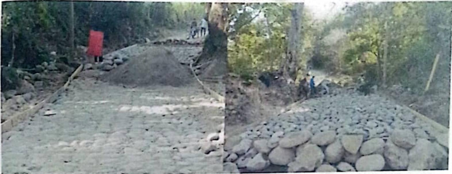
*Colocación de base de piedra del pavimento de concreto ciclópeo sobre la base conformada.*
