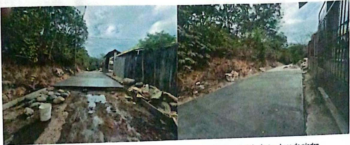
*Labores preliminares de encofrado, conformación de rasante y colocación de material selecto y base de piedra para elaborar el Pavimento de Concreto Ciclópeo.*
