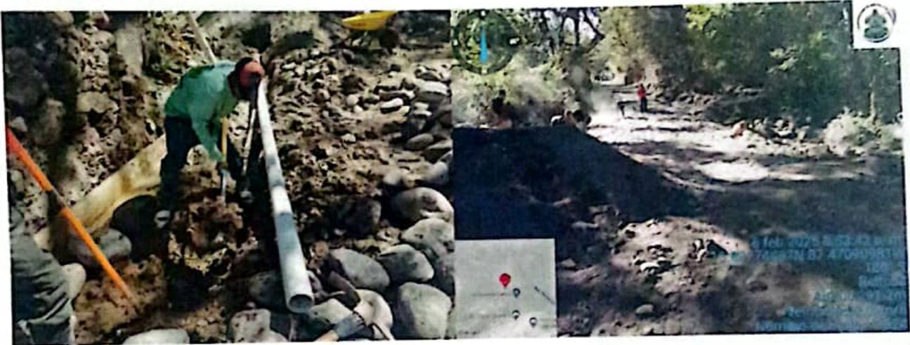
Labores preliminares de identificación de tuberías de agua potable y traslado de la misma a otra zona, así como limpieza y acarreo de material para la construcción de pavimento de concreto ciclópeo
