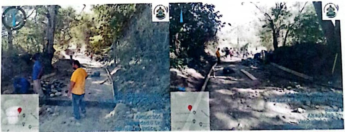
Labores preliminares de encofrado conformación de rasante y colocación de material selecto
