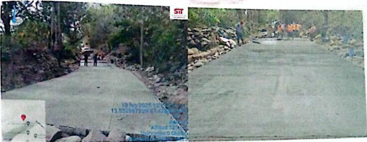
*Fundición de 85.00 metros lineales de pavimento con concreto ciclópeo*
