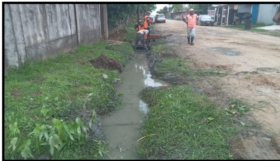
Limpieza de canales pluviales
