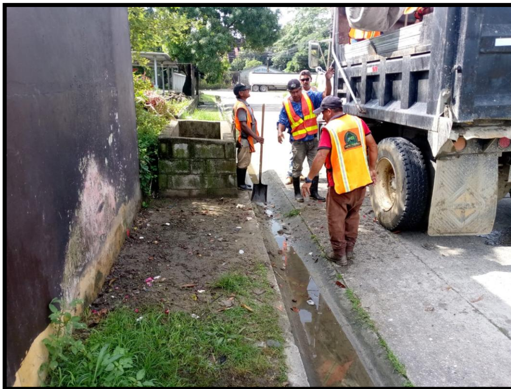
Limpieza de canales pluviales
