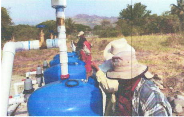
Instalación de filtro
